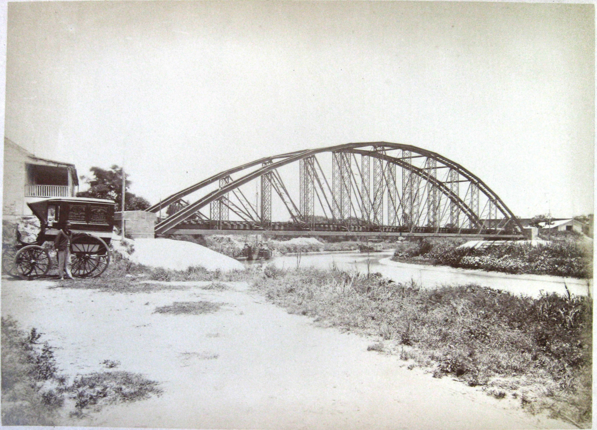
PUENTE DEL FERRO CARRILA LA ENSENADA
