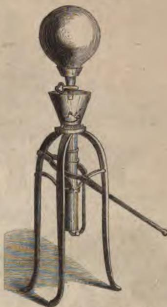
Fig. 114. Verbesserte Form der ersten Luftpumpe.
