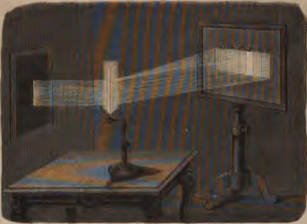
Fig. 184. Zerlegung des Lichts durch das Prisma.
