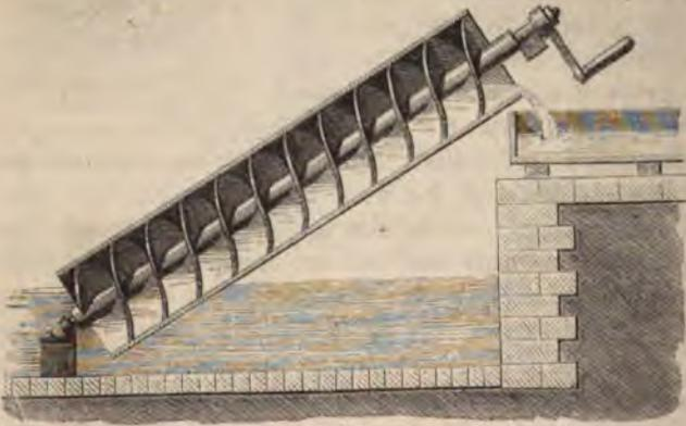
Fig. 139. Wasserschnecke.
