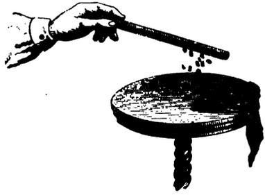
Fig. 250. Anziehende Kraft der Elektrizität.
