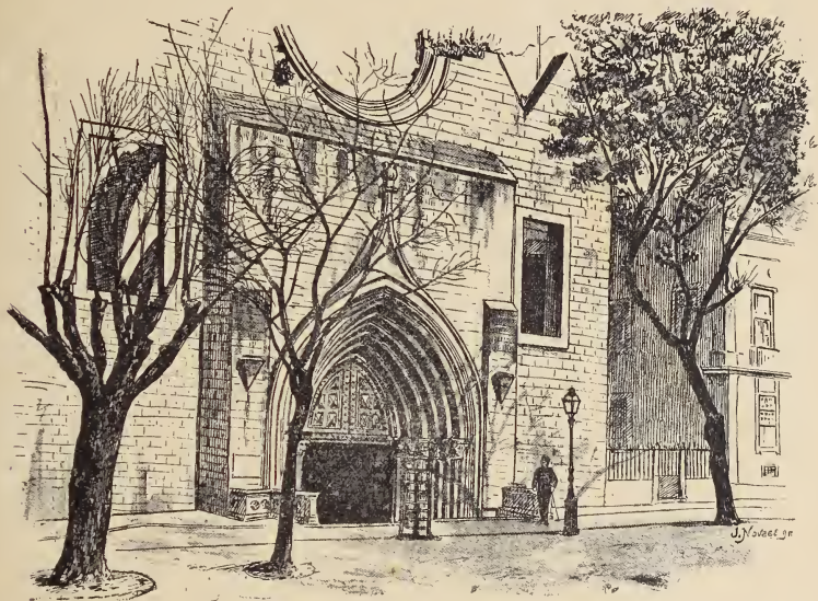
9 — Ruínas do convento do Carmo
