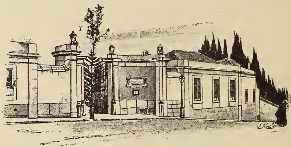
396 — Cemiterio do Alto de S. João. Entrada principal
