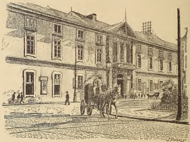
210 — Edifício do Arsenal da Marinha
