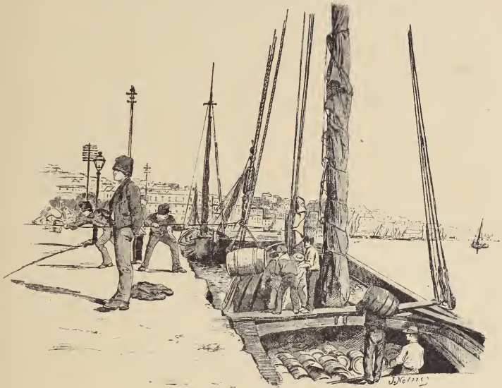
75 — No Aterro. Descarga d'uma falia
