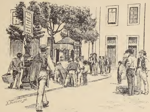
181 — O Largo de S. Roque, em dia de Loteria
