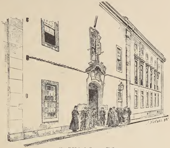
166 — Edifício do Governo Civil
