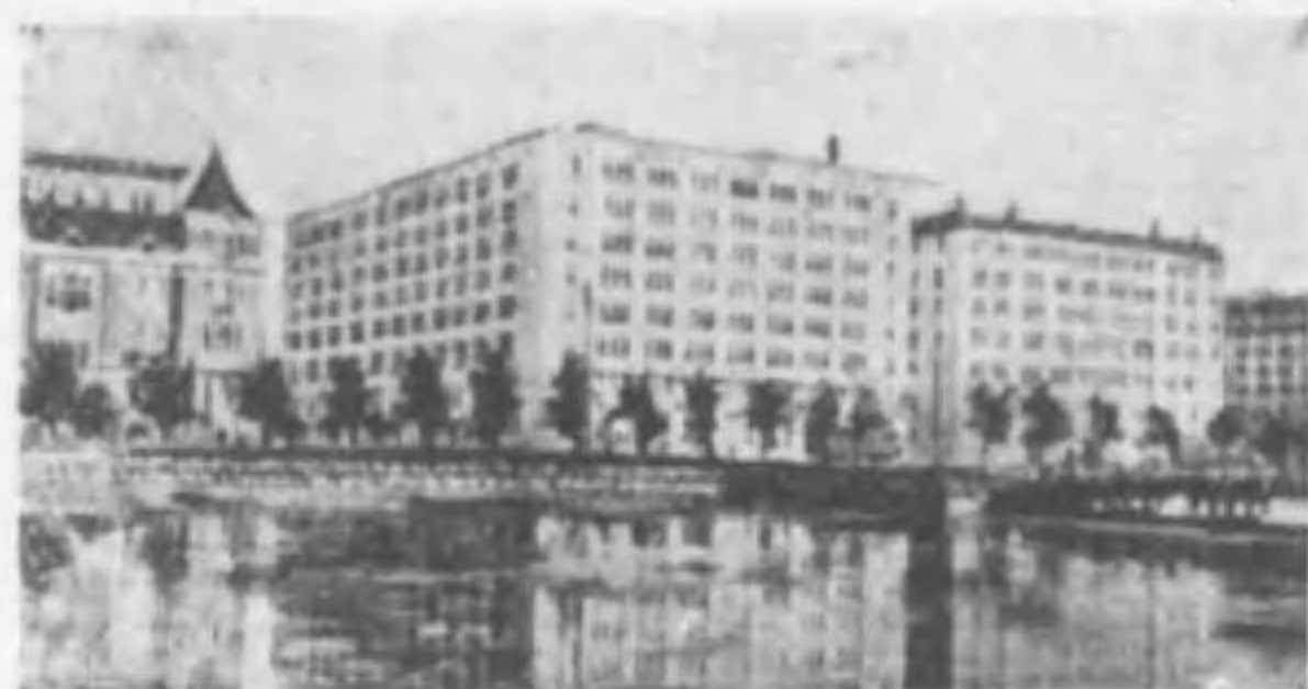
81. 鐵骨鐵筋コンクリートの建物
