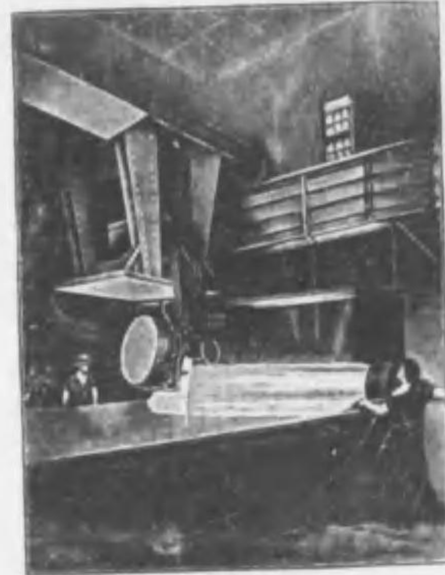
73. 厚板ガラスの製造 溶けたガラスを鋼のテーブルの上に流しロールで延べた後表面を磨き上げる
