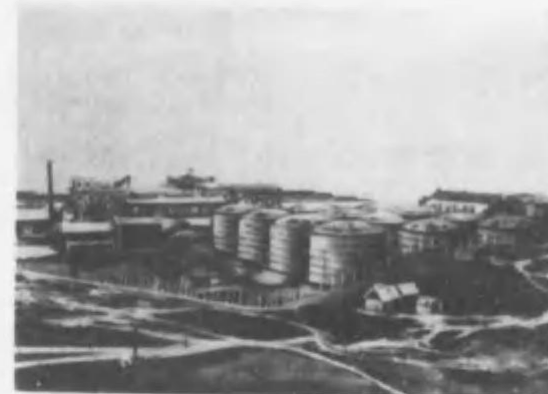
大豆油貯蔵槽
