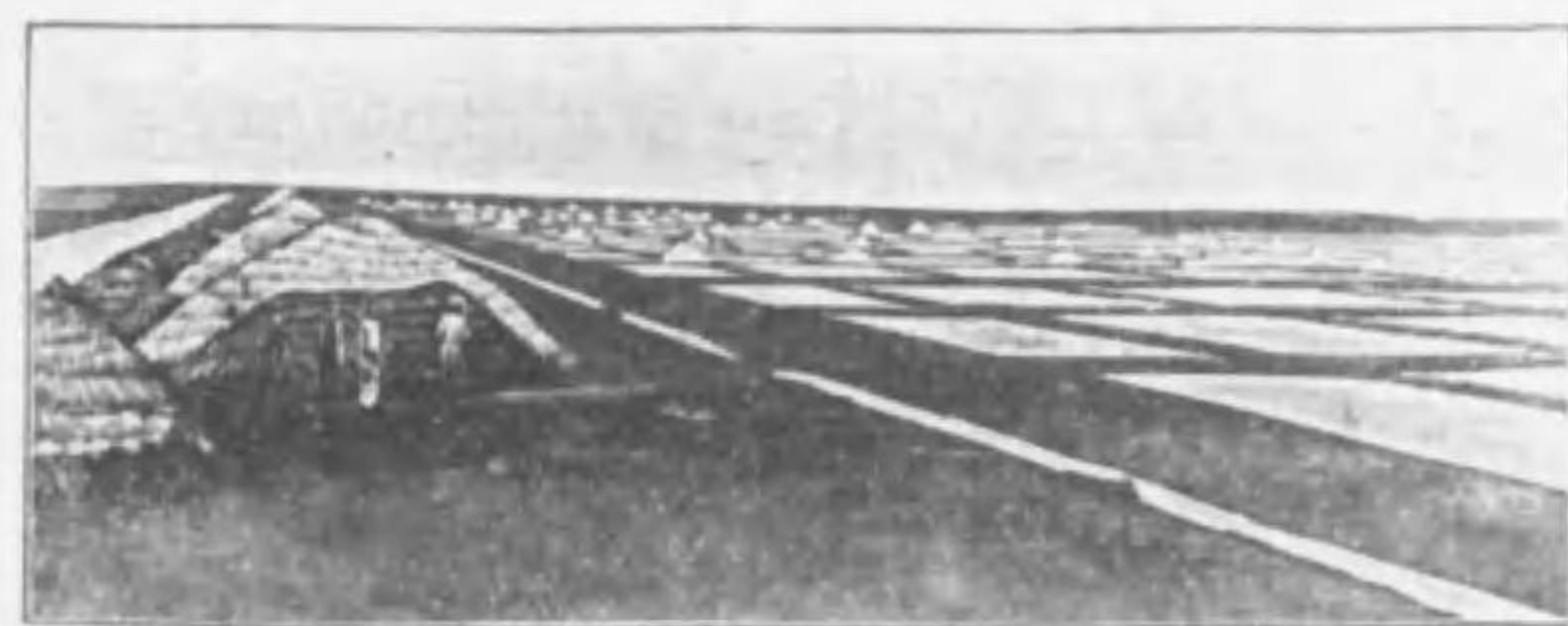
57. 關東州の天日製鹽 天日蒸發で直接に食鹽の結晶を造る
