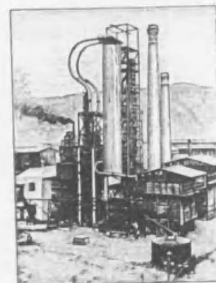
118. 製油所 前方に直立するのは蒸溜塔
