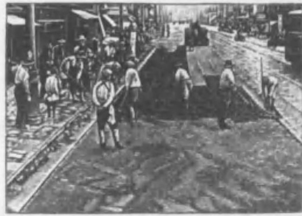
119. アスファルトで道路を舗装する
