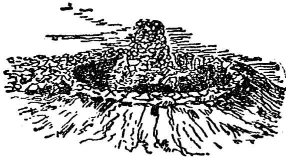
第五十一圖 石堆焚穢爐
