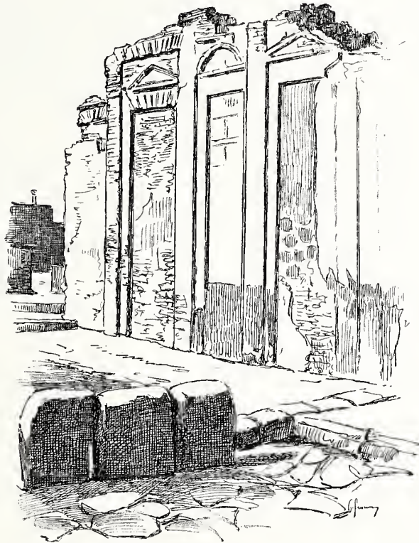
Album de l'édifice d'Eumachie. (Mur de la rue de l'Abondance.)
