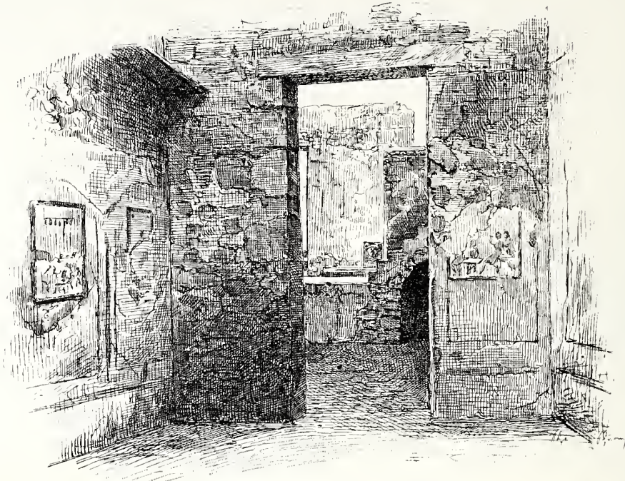
Intérieur de la thermopole de la rue de Mercure.
