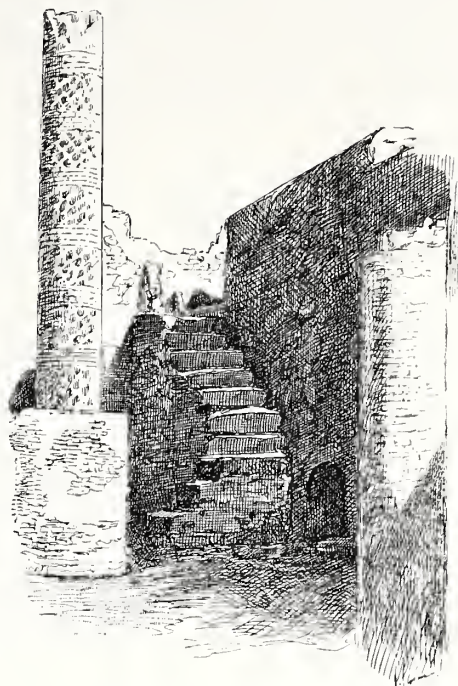
Escalier. (Région VII, Insula VI.)
