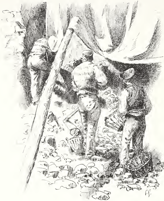
Les ouvriers des fouilles.
