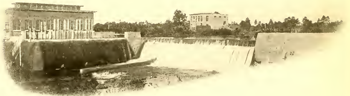
WATER POWER, ALBANY, GA., S. A. L. RY.
