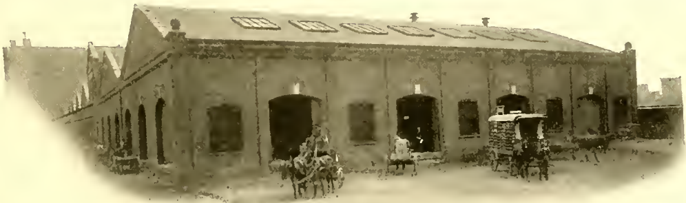
FREIGHT DEPOT OF THE S. A. L. RY., ATLANTA, GA.
