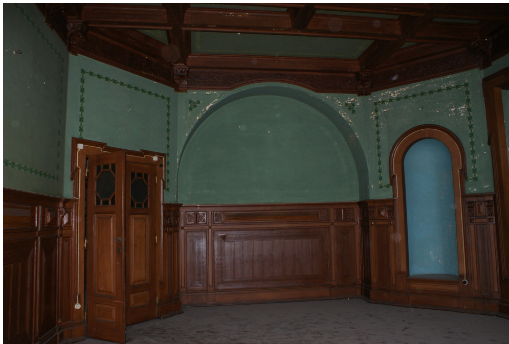
Figura 19 – Vista do escritório e respectivo tecto em caixotões. Fotografia de Mónica Romãozinho.
