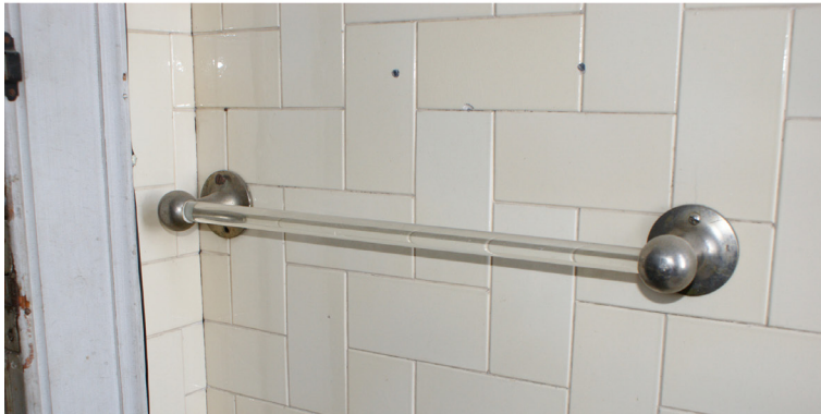
Figura 34 – Lavatório integrado nas toilettes dos quartos, com suportes em ferro trabalhado. Toalheiro em cristal que surge aplicado nas mesmas dependências e no wc. Fotografias de Mónica Romãozinho.
