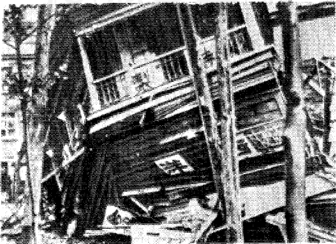
圖片四東京大地震的影響 一九二三年東京發生大地震，死二十萬人，損失重大。圖片中鋼筋混凝土的建築物還能保存不倒，普通房屋全部倒塌。
