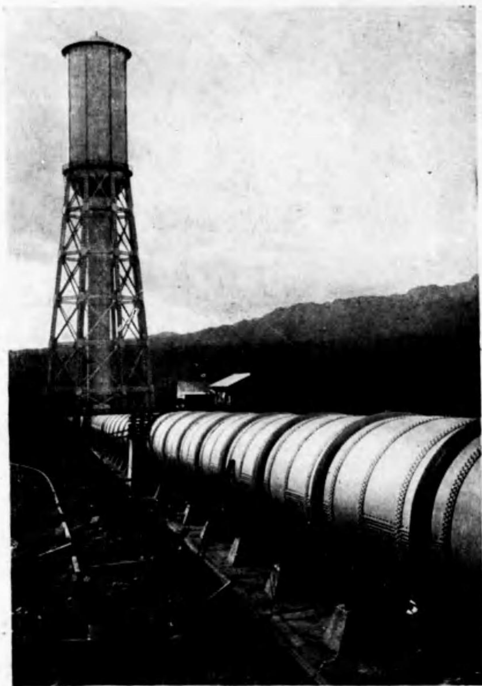
関東水力佐久発電所の大サージタンクと導水管 (利根川筋伊香保澁川課東南丘上にあり車窓より見ゆ) 高さ 80m, 内径 12.5m, 容量 3,650m 3 , 使用鐵材 1,000 噸, 工費 50 餘萬圓 (水車第86頁參照)
