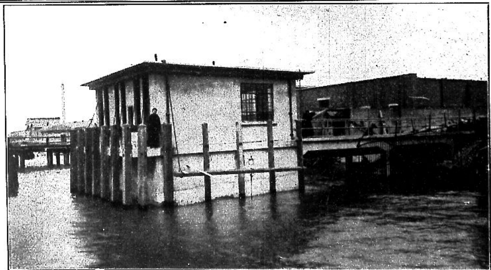
⇒ 浦東水廠 混水進水閘
