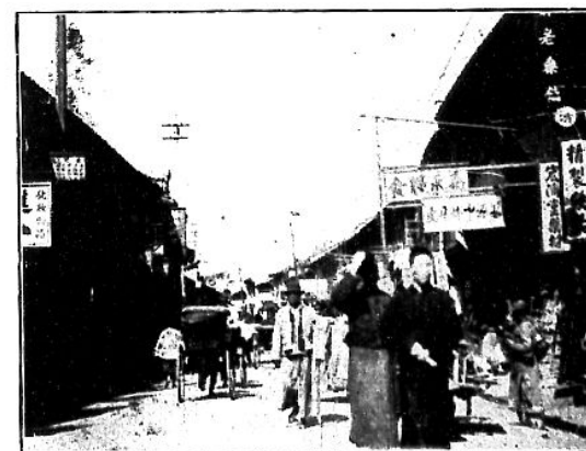
拆除跨街廣告後之肇嘉路
