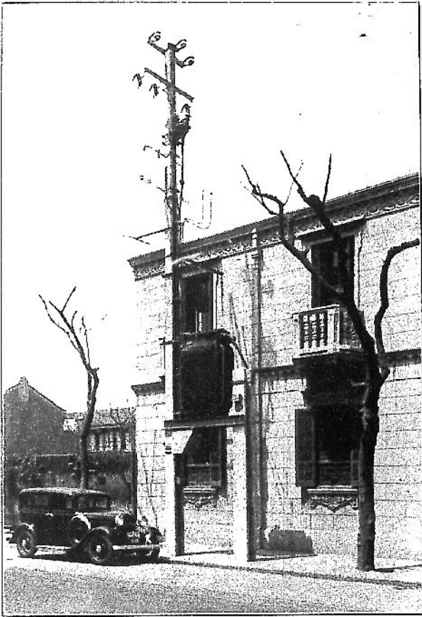
↑ 滬西電力公司架空 綫及露天變壓器
