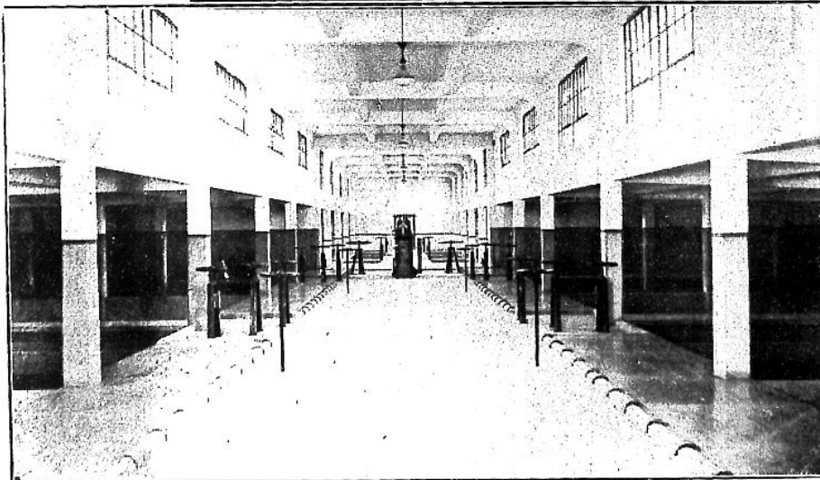
← 關北水電公 司水廠新擴 充快濾池
