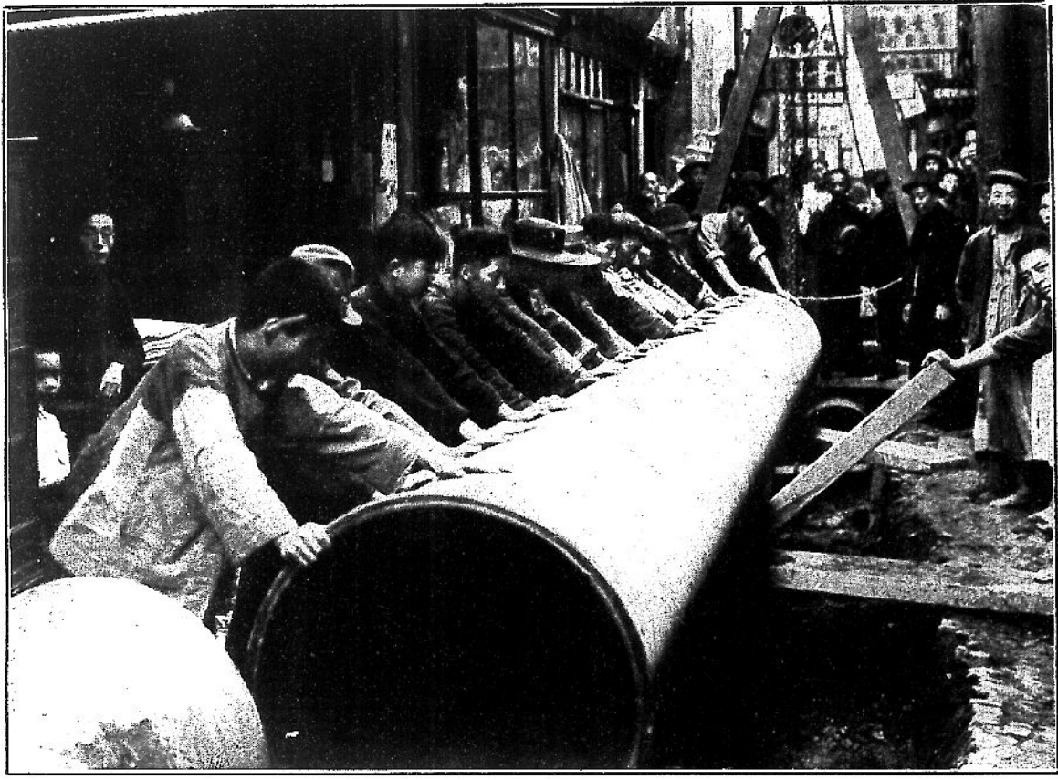
內地自來水公司埋設七六二公厘鋼管工程
