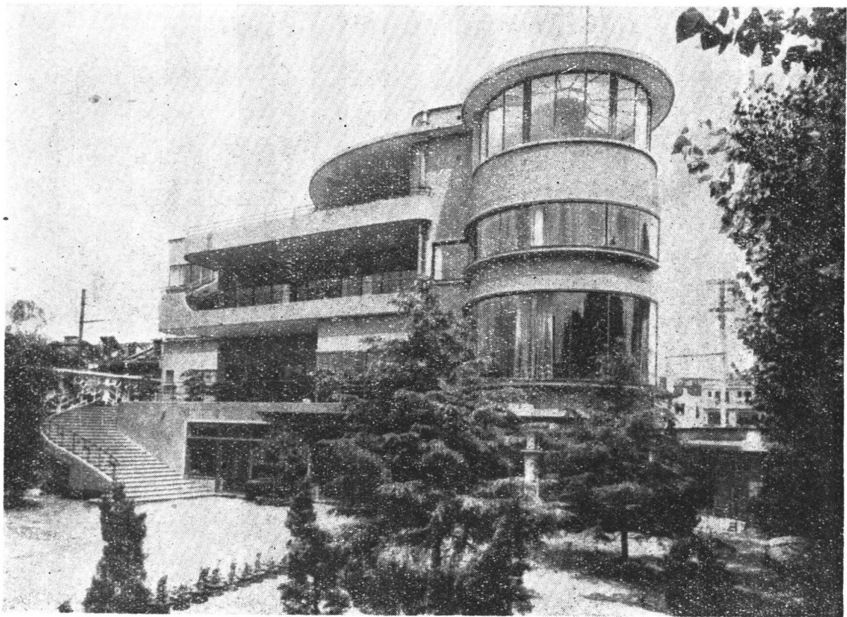
图 2-71 上海北京路某住宅外观
