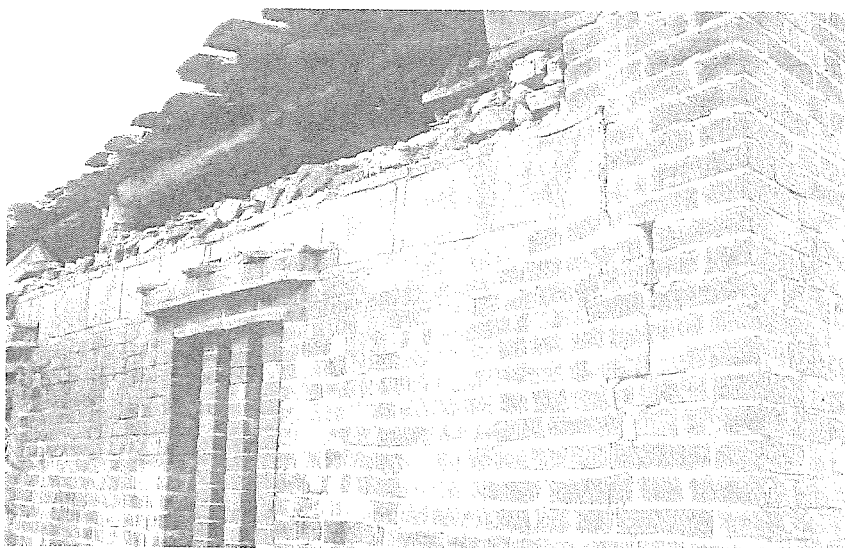
• 去年的兩次地震，讓郭氏祠堂受傷不輕，木造結構略微移位，磚砌部分已呈裂縫，屋瓦幾處嚴重脫落，修復問題迫在眉睫。（陳素雲攝）
