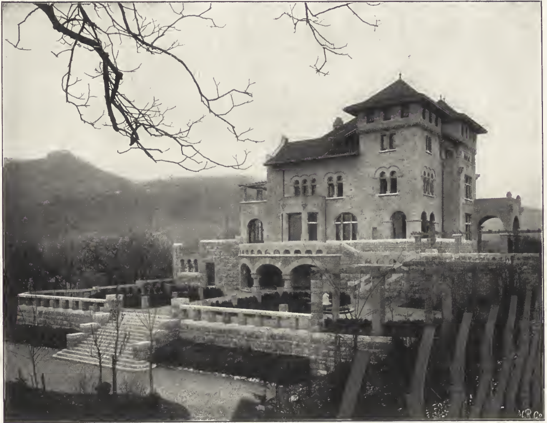
CURJEL & MOSER, ARCHITEKTEN, KARLSRUHE. Villa C. E. L. Brown in Baden (Schweiz). Garten-Ansicht.
