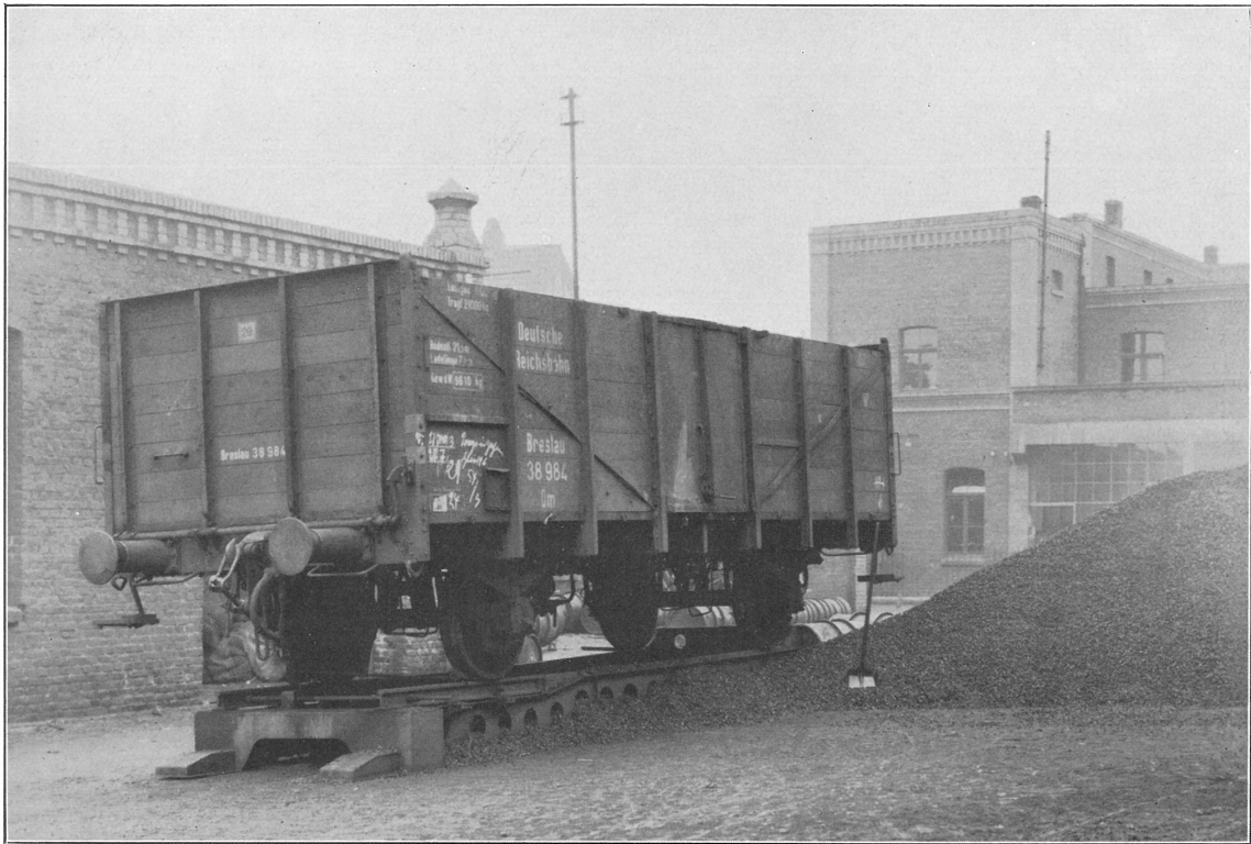
Bild 23. Kohlenwagen auf dem fahrbaren Absetzgleis im Werkhof bei der Entladung (Firma Pongs & Zahn, Viersen)
