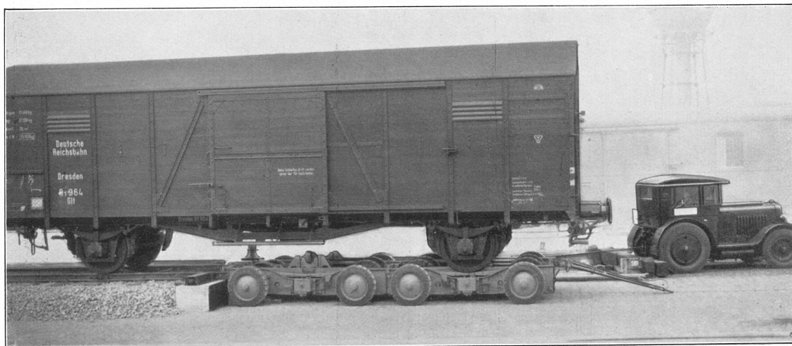
Bild 6. Auffahren eines großen gedeckten Güterwagens (Gattung Glt) von der Überladerampe auf das zusammengeschobene Straßenfahrzeug
