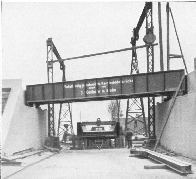
Bild 41. Zufuhr einer geschweißten Brücke mit einem Straßenfahrzeug zur Baustelle und Montage der Brücke
