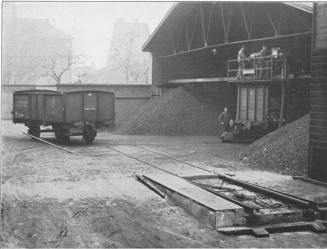
Bild 15. Feste Absetzanlage mit Drehscheibe und zwei Stischgleisen im Hof des Kesselhauses (Firma Kaiser, Viersen)
