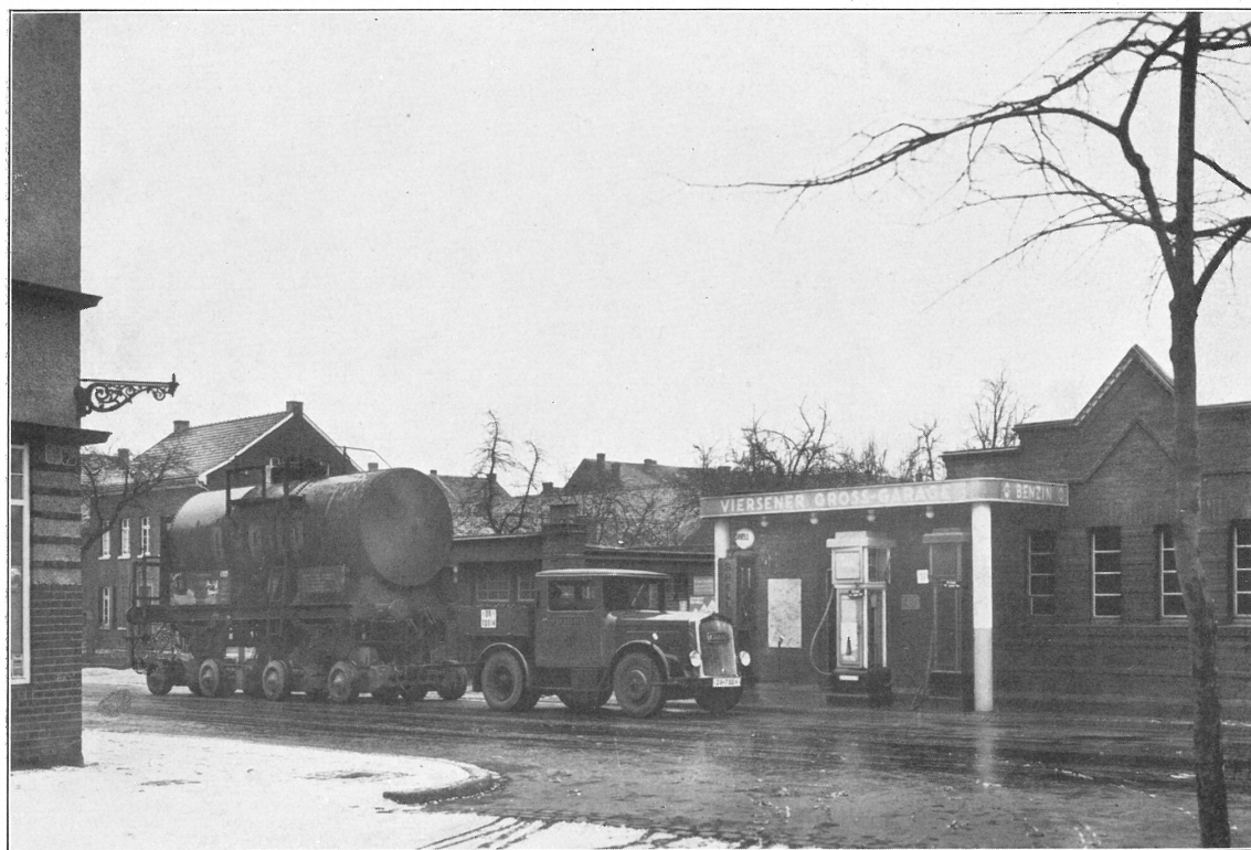
Bild 24. Der Eisenbahnkeßelwagen wird zur Tankstelle gerollt
