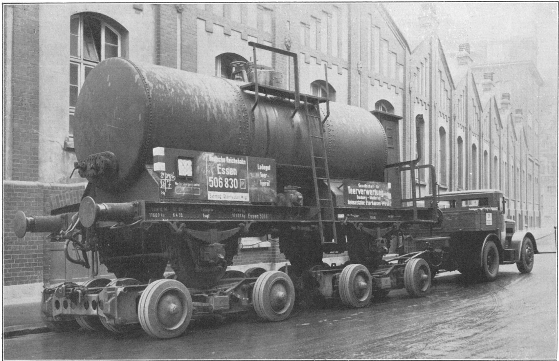
Bild 20. Entleerung eines Kesselwagens mit Heizöl für die Backöfen der Firma Kaiser, Viersen
