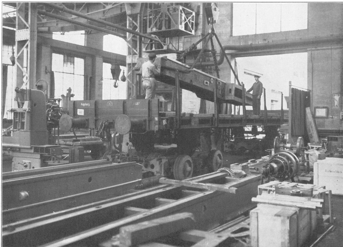
Bild 46. Verladen einer Hobelmaschine auf dem Sm-Wagen (8 m Achsstand) in der Montagehalle der Werkzeugmaschinenfabrik und Eisengießerei von Billeter & Klunz A/G, Aschersleben
