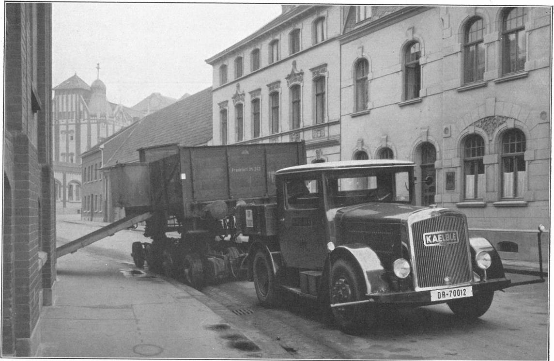
Bild 18. Koksentladung an der Koksfabrik von der Straße aus (Firma Kaelble, Viersen)
