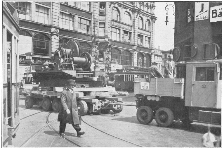
Bild 35. Transport einer 20t schweren Dampfbauwinde durch die Straßen Berlins
