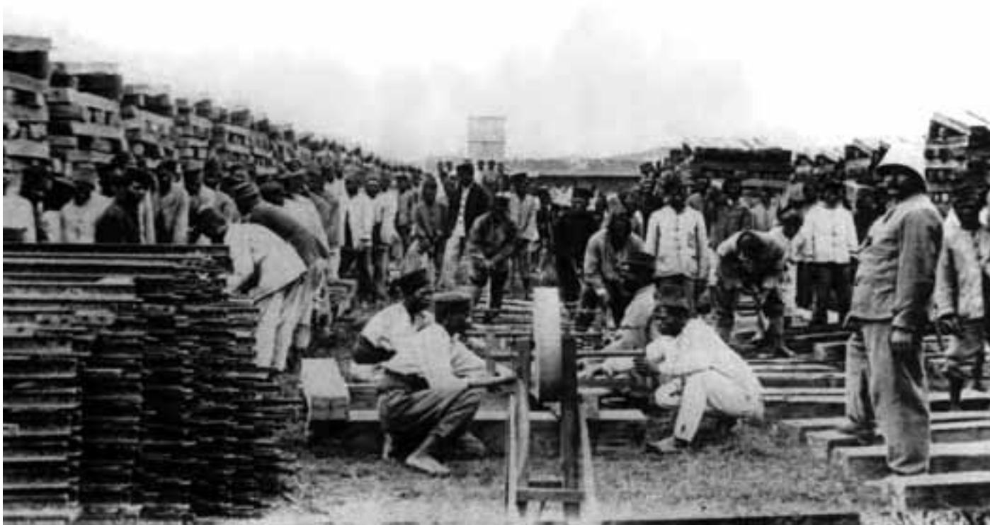
FIGURA 10.5 Madagáscar: trabalhadores empregados na construção da estrada de ferro de Tananarive – Tamatave. (Foto: Harlingue-Viollet.)
