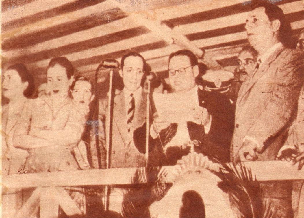
El General Perón y su incansable y leal colaboradora, Eva Perón, asisten a la inauguración del acueducto Río Tercero, en San Francisco, Provincia de Córdoba, el 4 de marzo de 1948.
