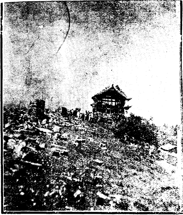
大地理地震時城樓塌卸之狀況一
