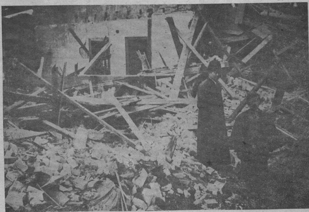
房 屋 被 炸 彈 炸 毀 的 情 形
