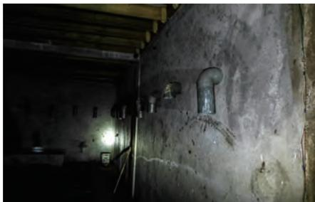
牆壁的水管連接到外面達到空氣流通的效果。
