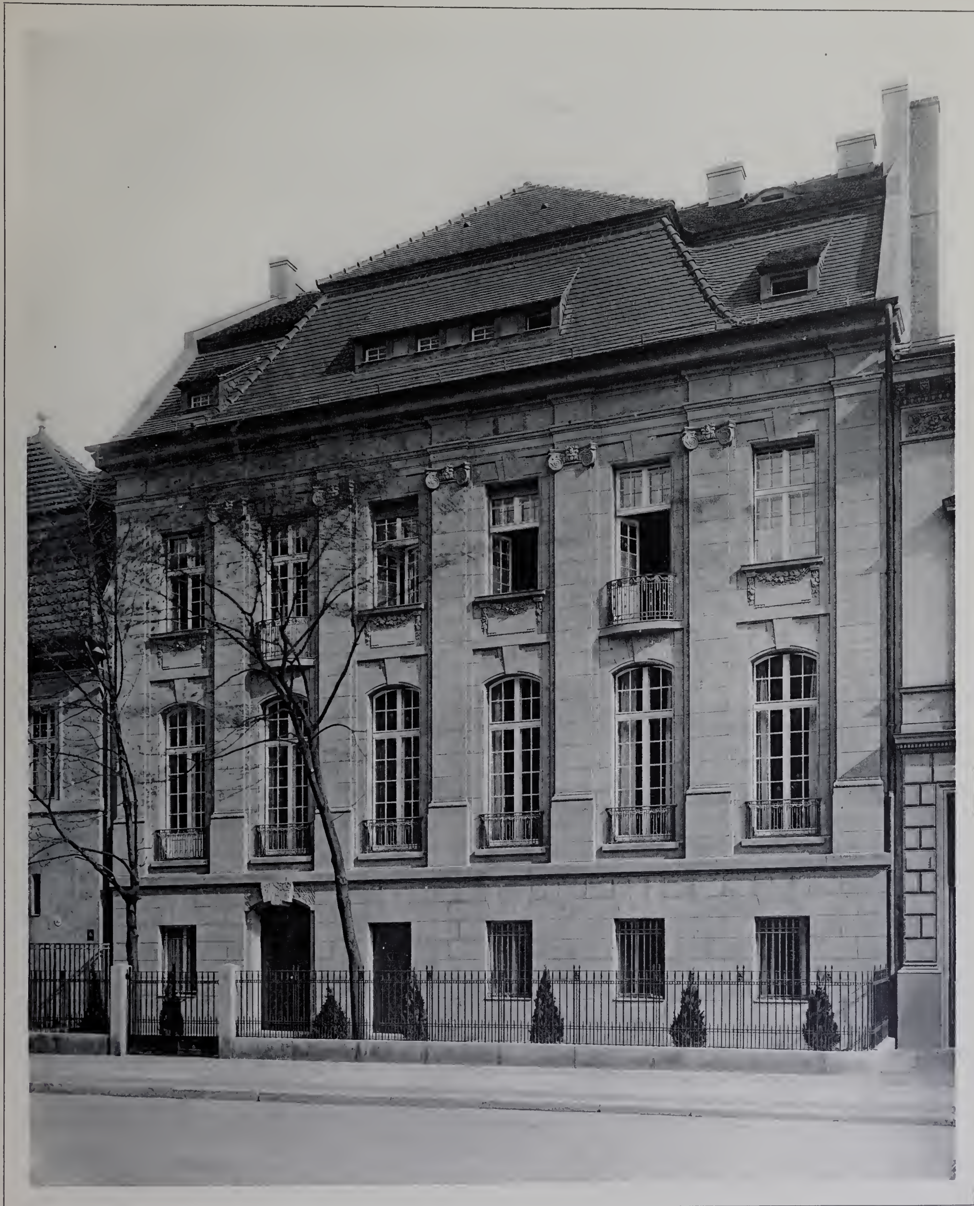
Architekt: Peter Dybwad, Leipzig.
