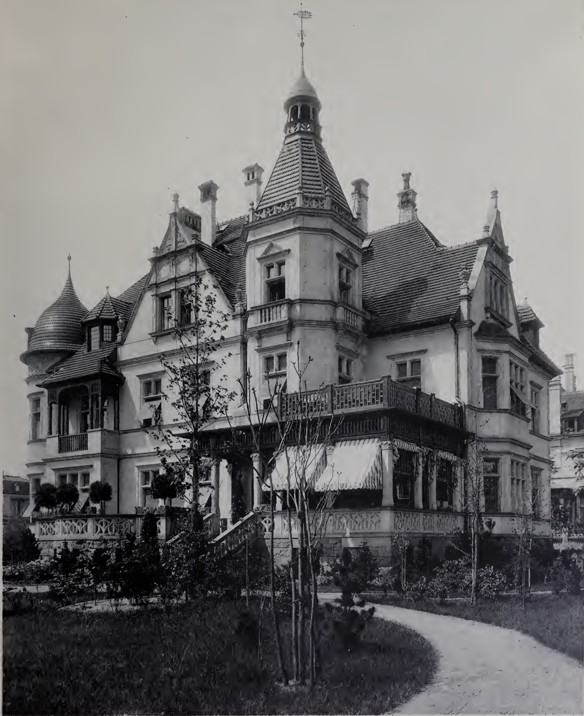
Architekt: Peter Dybwad, Leipzig.
