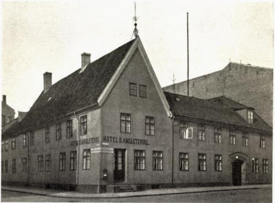
Hotel d'Angleterre. Opført 1668. Efter fotografi.
