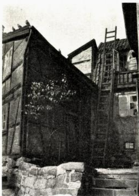
Fra Hammersborg. Smuget fra Maschmanns gate op til Bjerggaten, parallelt med Kanten paa sydsiden. Efter fotografi.
