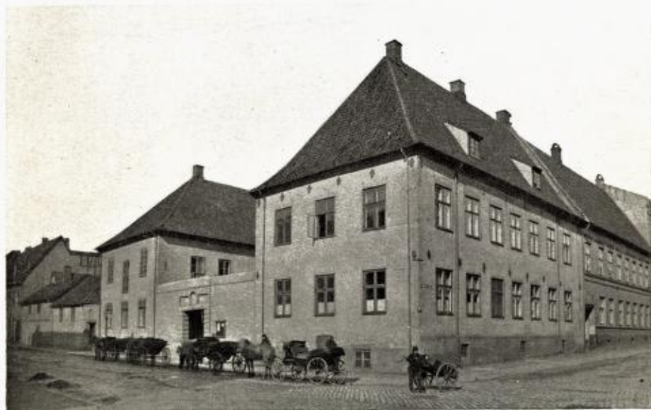
Det gamle raadhuset. Opført 1647. Efter fotografi.
