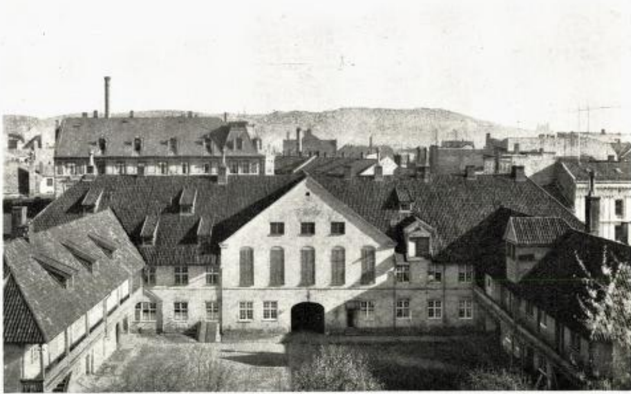
Tukthuset i Storgaten, opført 1737—40. Gaardssiden. Efter fotografi.
