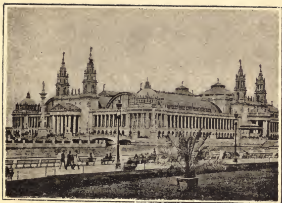
PALACIO DE MAQUINARIA
