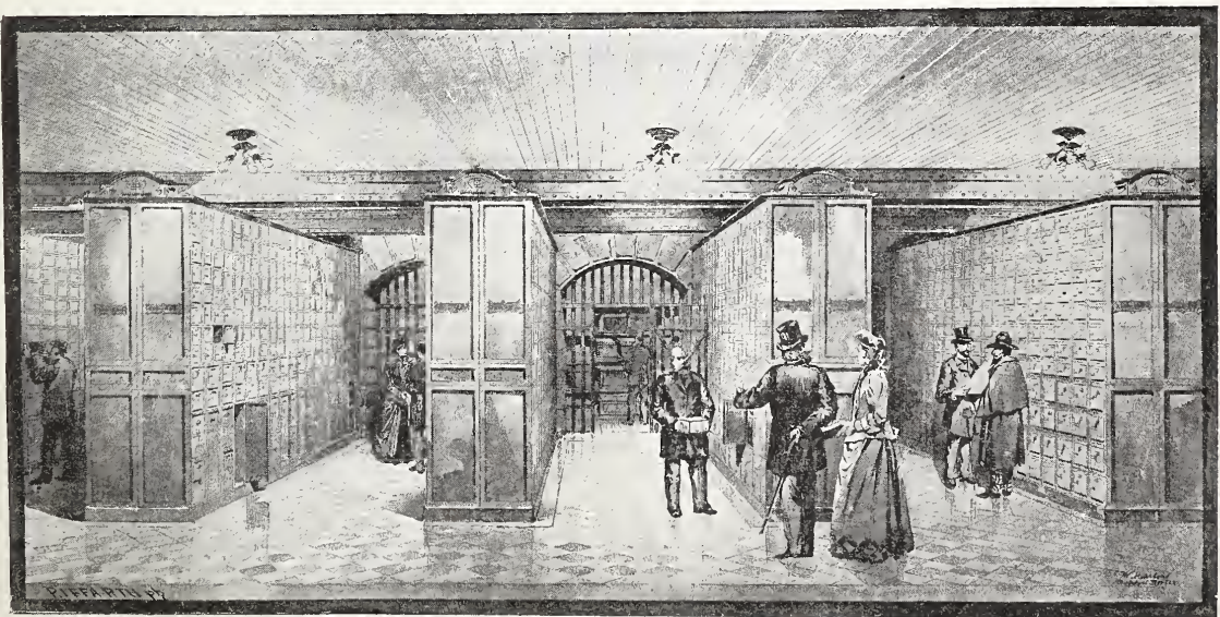
Abbildg. 9. Blick in die Stahlkammer.
