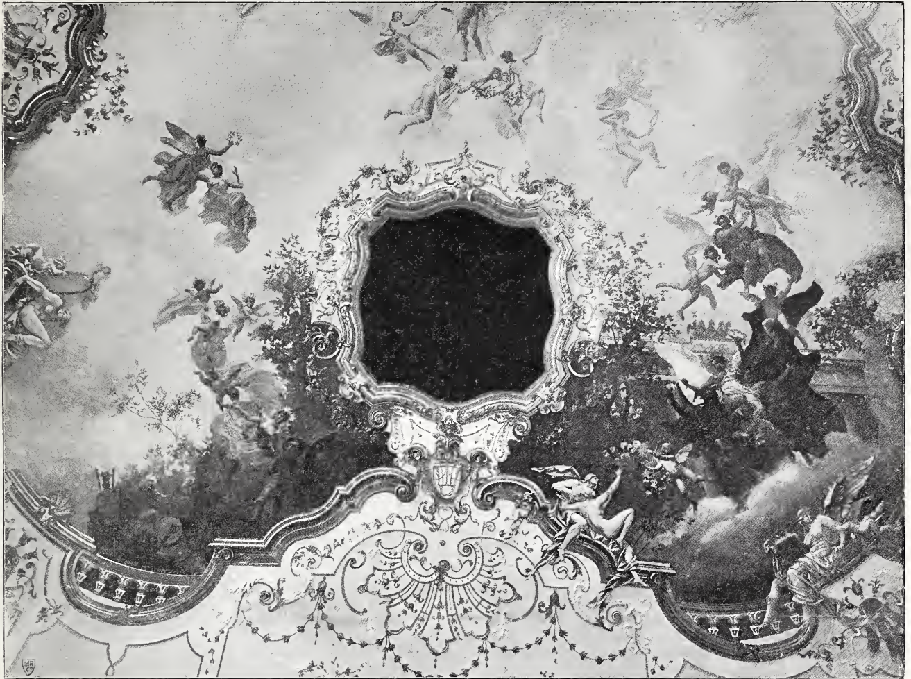
Theil der Decke des Zuschauerraums mit dem Gemälde von E. Veith vor Einbringung des Kronleuchters.
