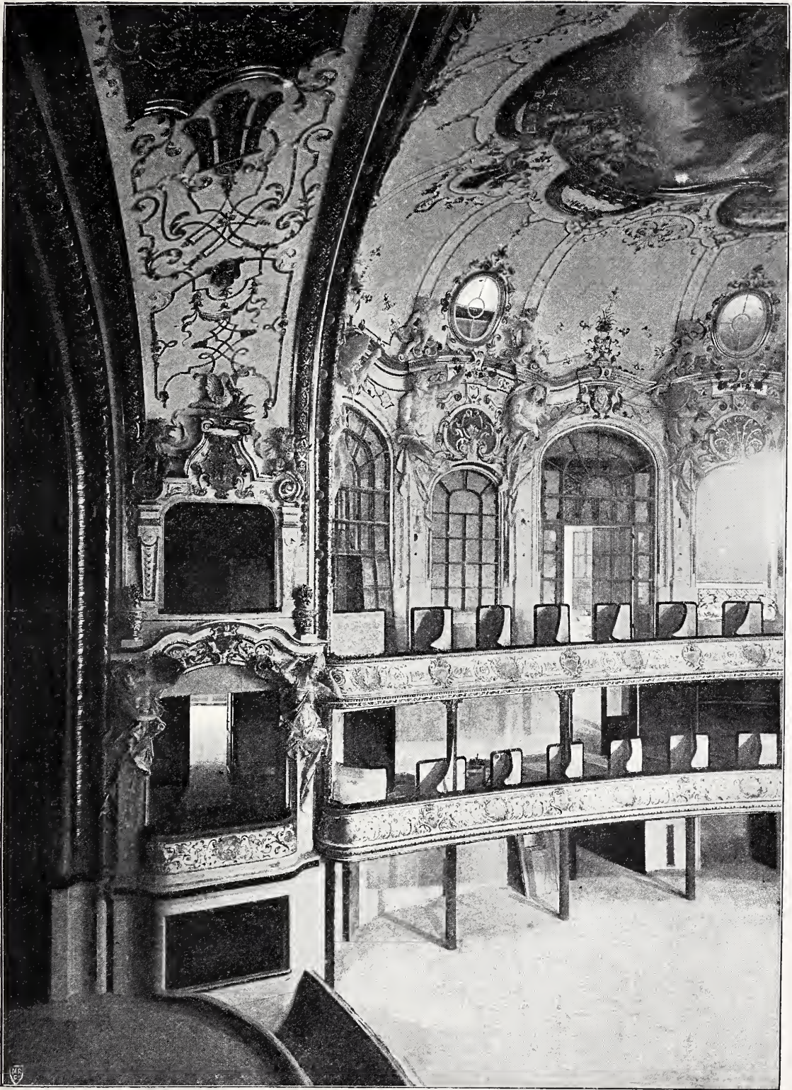
Innensicht des Theaterraumes vor Einbringung der Ausstattungs-Gegenstände.
