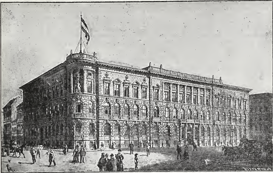
Deutsche Bank in Berlin. (Arch. W. Martens). Abbildg. 1. Hauptfassade.
