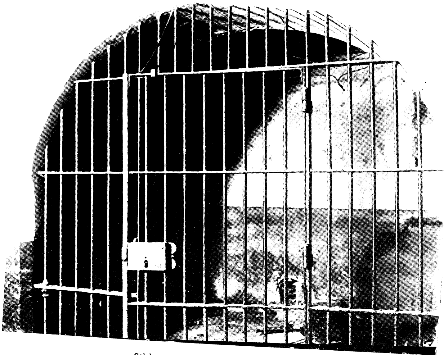
Calabozos anteriores deteriorados y reformados.
