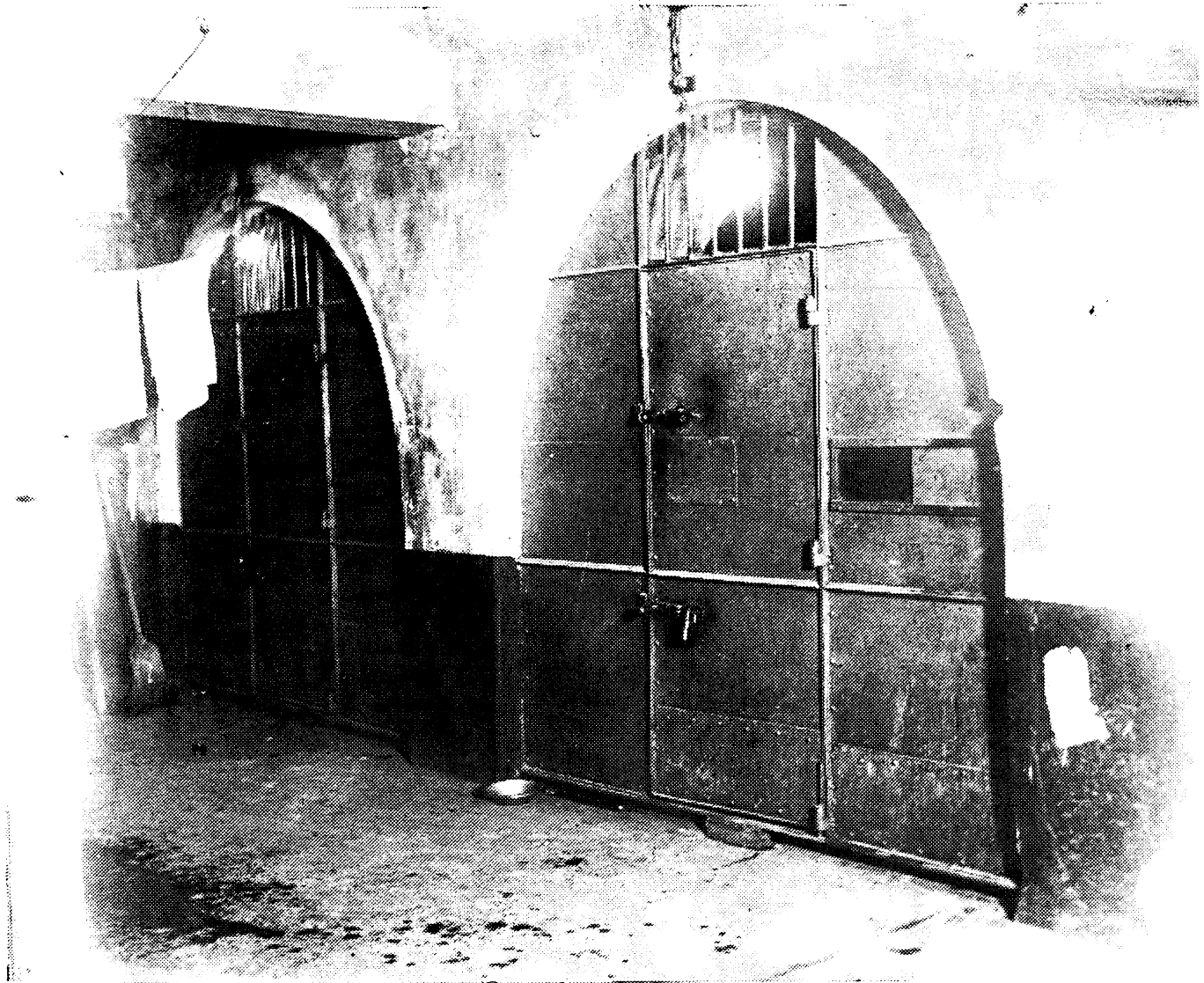
Calabozos anteriores deteriorados y reformados.
