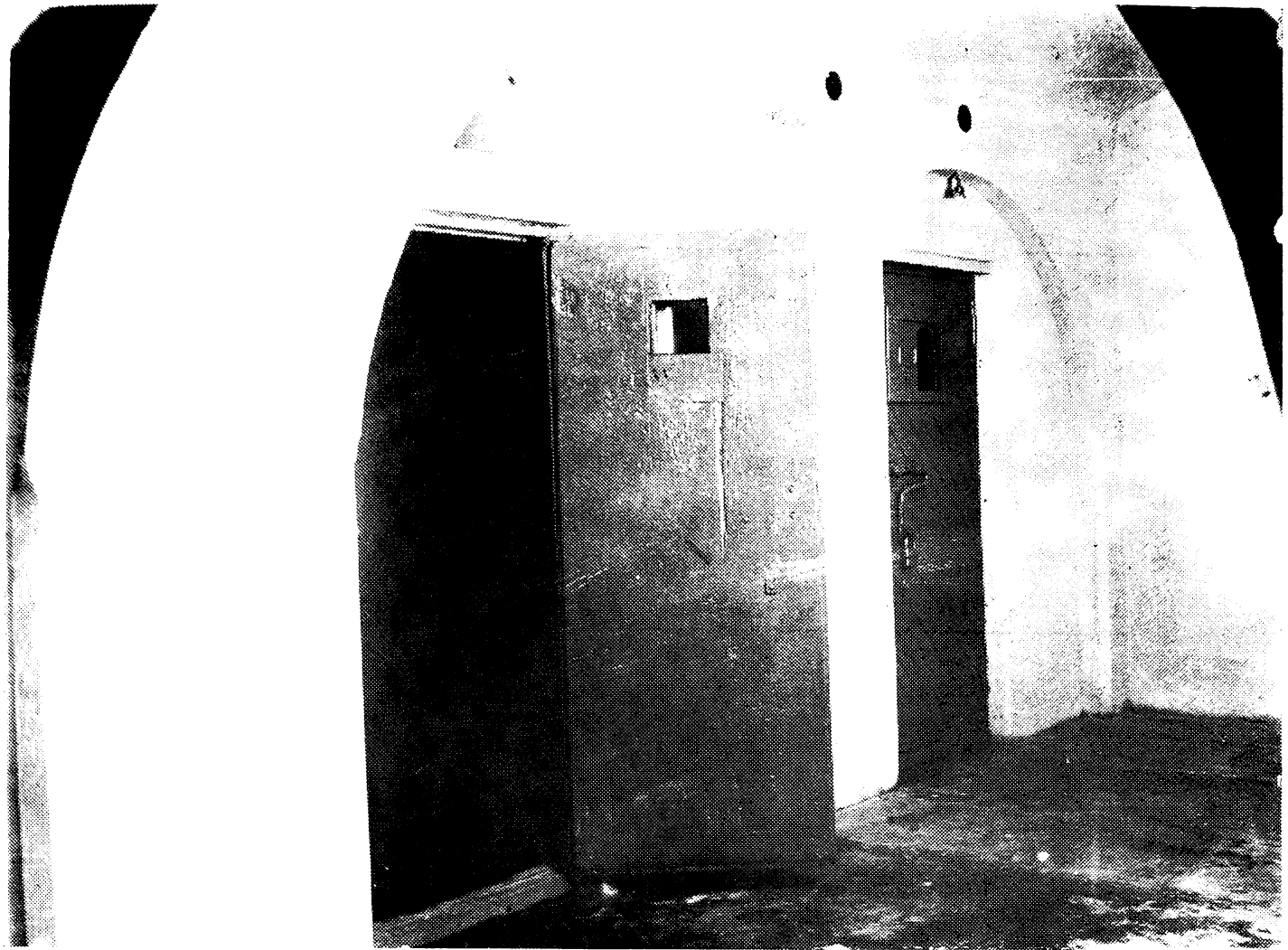
Calabozos anteriores deteriorados y reformados.
