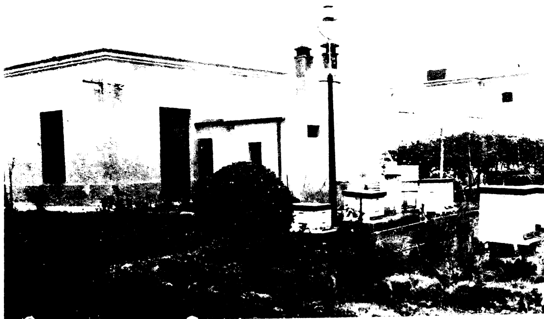
Vista del local de la enfermería, tomada del lado izquierdo.
