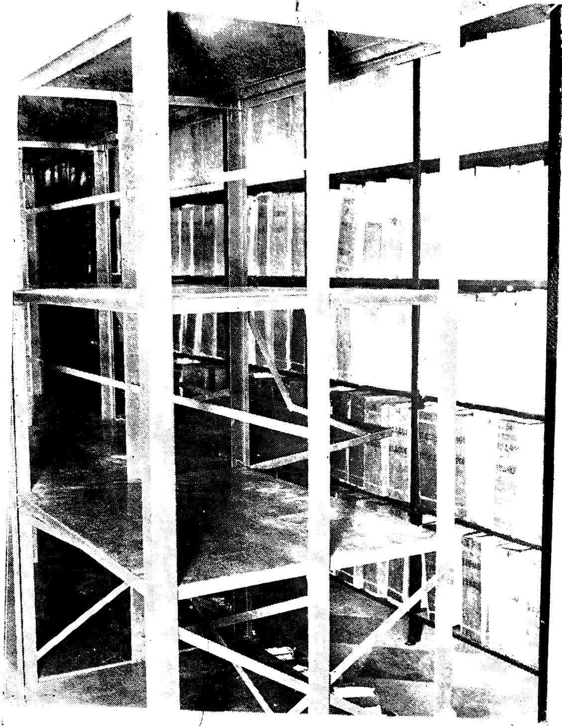
Nueva estantería de acero para el archivo de prontuarios, mostrando sus bandejas reforzadas. Encuéntanse colocadas en el subsuelo.
