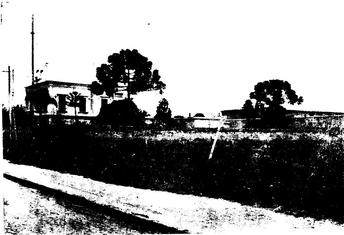
La cárcel vista de la calle lado Norte.
