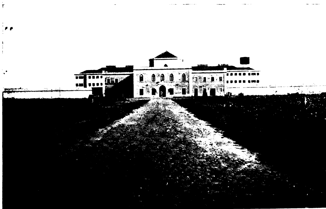
Vista del frente del edificio y muro.
