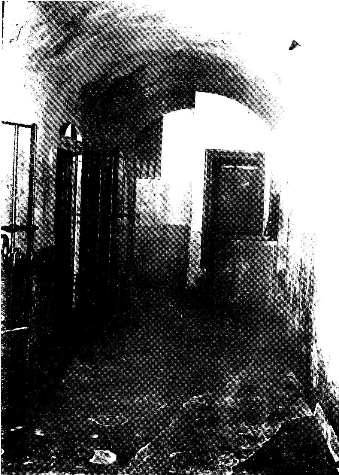
Calabozos anteriores deteriorados y reformados.
