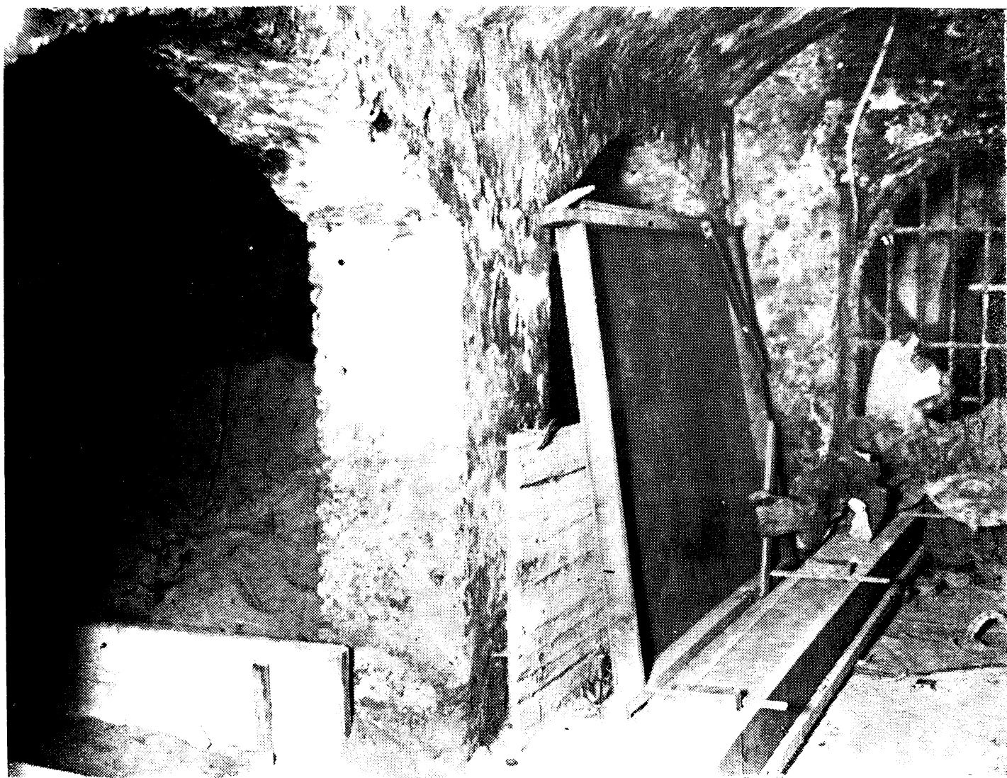
Estado en que se encontraba el subsuelo donde se construyó parte del nuevo archivo para prontuarios.
