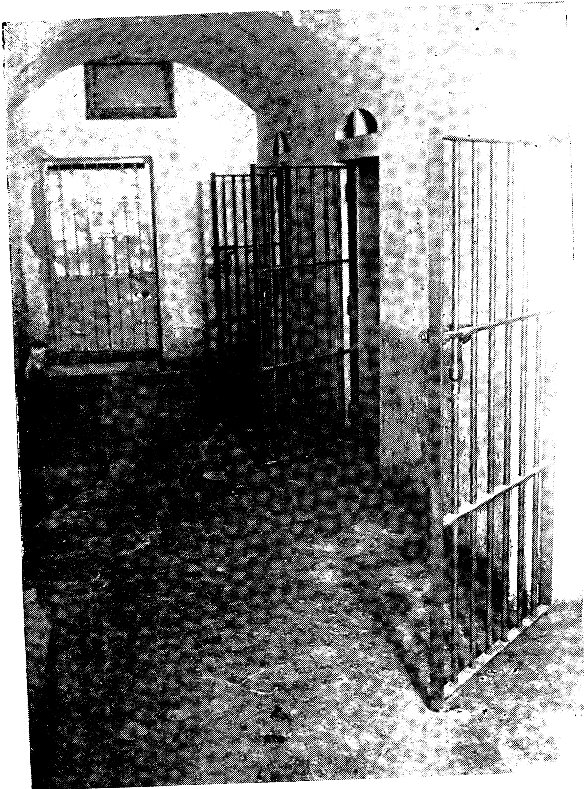
Calabozos anteriores deteriorados y reformados.
