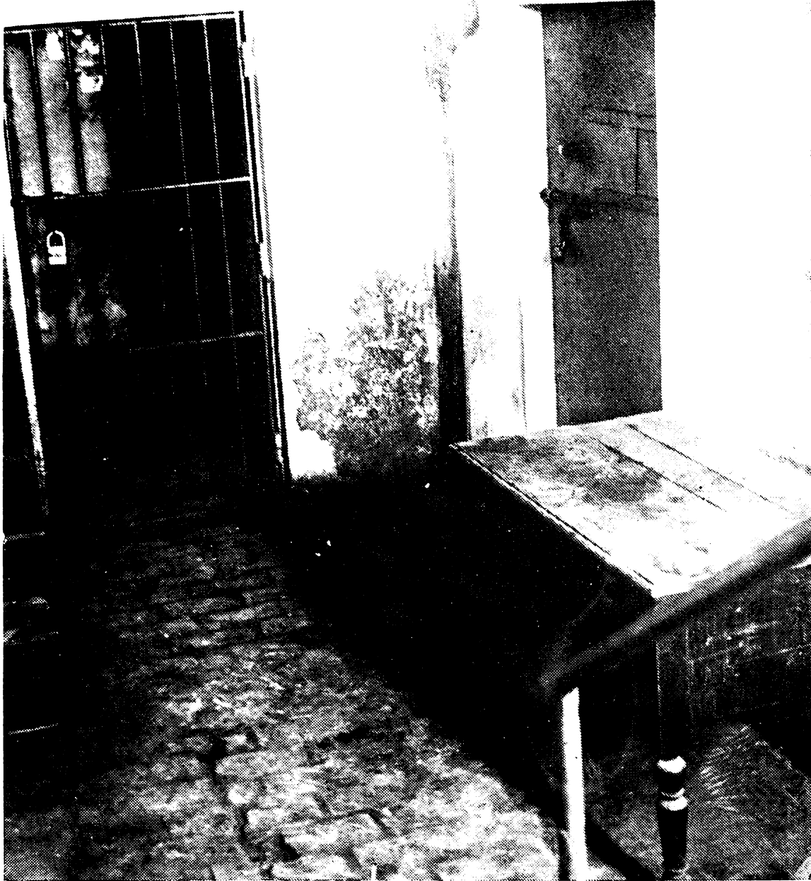
Calabozos anteriores deteriorados y reformados.
