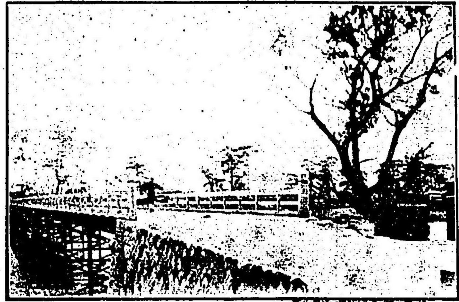
龍野揖保川樟津橋
