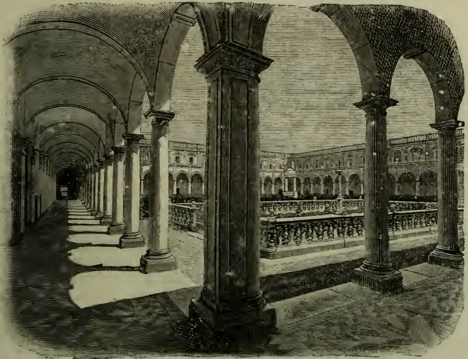
CLOISTERS OF S. MARTINO.
