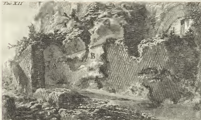
Avanzo del Condotto dell'Acqua Albolina. A. Spoco del condotto fabbricato di opera incerta, ed avanzi si nell'opere che nell'incarna di opera reticolata. B. Intarsatura dell'opera reticolata dell'opere della spoca, composta di tessere e pezzi. C. Lastrova composta di tessere e pezzi. Di Michel Sestini del Tav.
