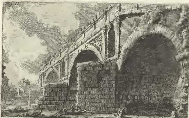
Veduta del Ponte Rotto. A. Arco dell'antico Ponte Sublico alla riva del Trastevere. B. Archi moderni. C. Avanzi della pila antica sulla riva opposta. Piranesi Archit. dis. inc.
