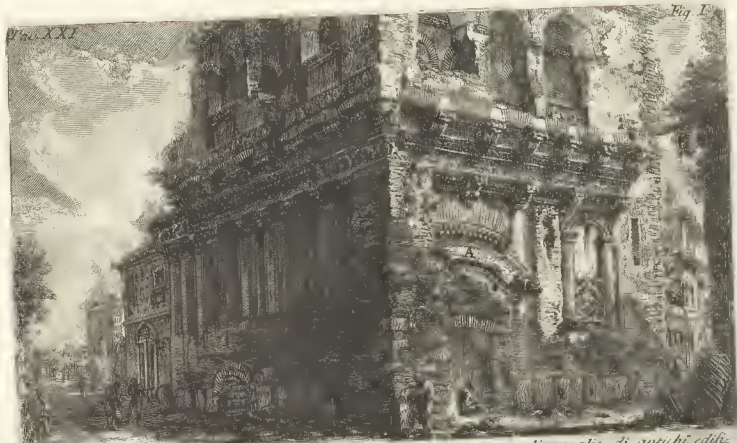
Veduta dell' avanzo della Casa di Nicolo di Ranzo fabbricata di speghe di antichi edife- zj, in contro la Chiesa di S. Maria Egiziaca ~ Piranesi Archit. Sc. Inc.
