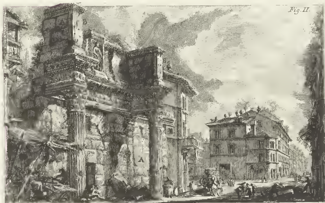
Veduta di altri avanzi del predetto Foro di Nerva detti le Colonnate. A Pareti e pilastrelli di peperini, ch'erano inseriti di marmi. B Buclii ne pilastrelli, ov'erano impiombati i perni che reggevano gli ornamenti di bronzo. Piranesi Architetto del. inc.
