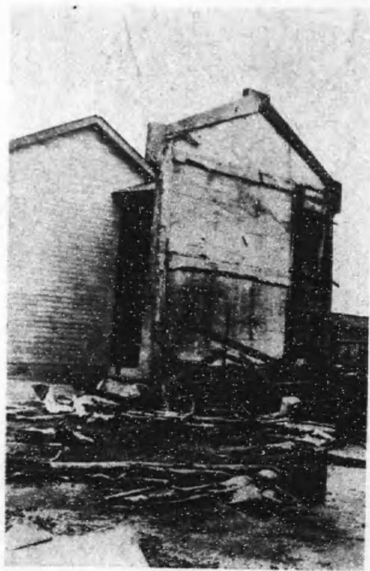
第5・4圖 防火壁の構造とその防火効力を示す實例
