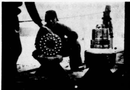
於螺旋帽與托板之間置徑 13 吋之鋼盤二個，上盤與螺旋帽連接，隨螺旋帽而轉動，下盤連於一盤座上，盤座置於托板上，不能轉動。兩鋼盤之間，置徑大  $1\frac{1}{2}$  吋之鋼球 32 個。（參看第十
