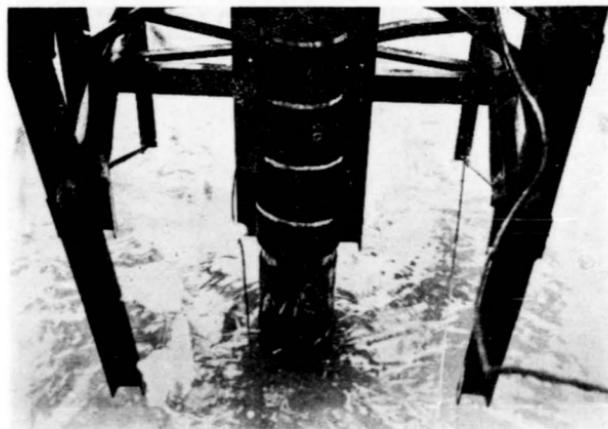
透樁已套於木樁頂上之情形旁有鉛絲所以驗木樁是否被打斷或彎曲也
