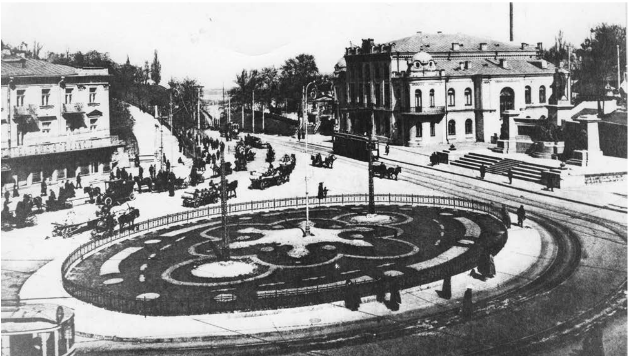
Царська площа. Під цією клумбою був головний збірний резервуар міської каналізації (1894 р.)
