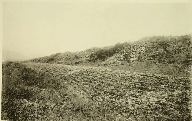
一六六 通溝城北壁外面 一六七 同 城西壁外面下部 一六八 同 城發見瓦 木甍蓋
