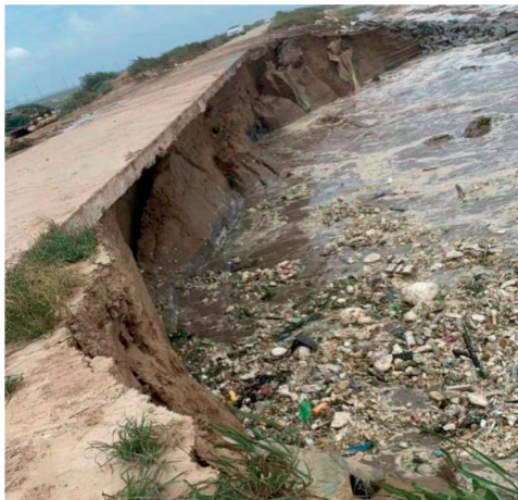
图4 江苏省射阳市海堤受损 拍摄时间：2021.7.28 坐标：33°49'N, 120°31'E
