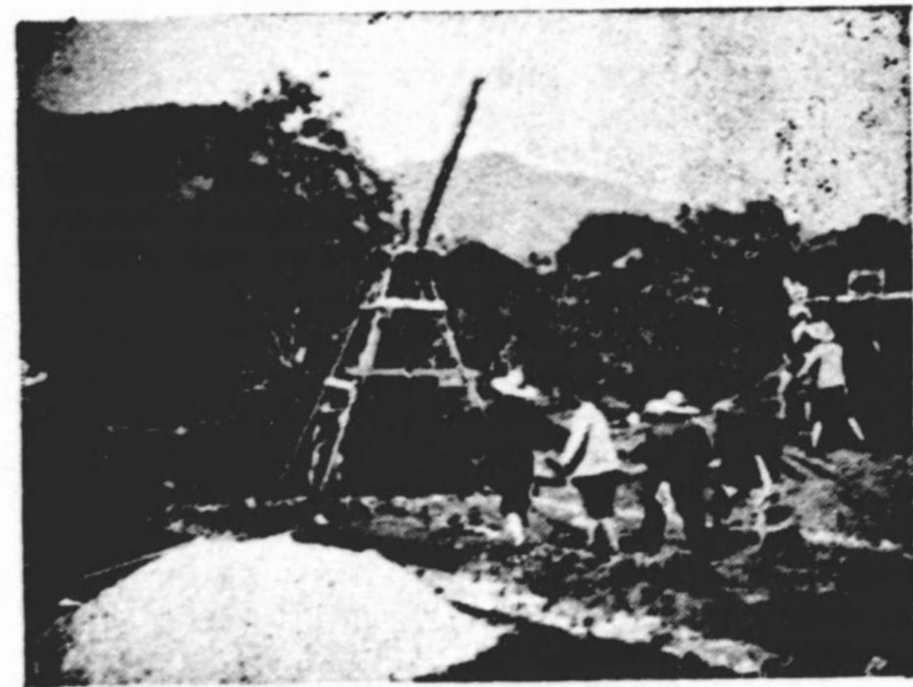
圖書館基礎工事
