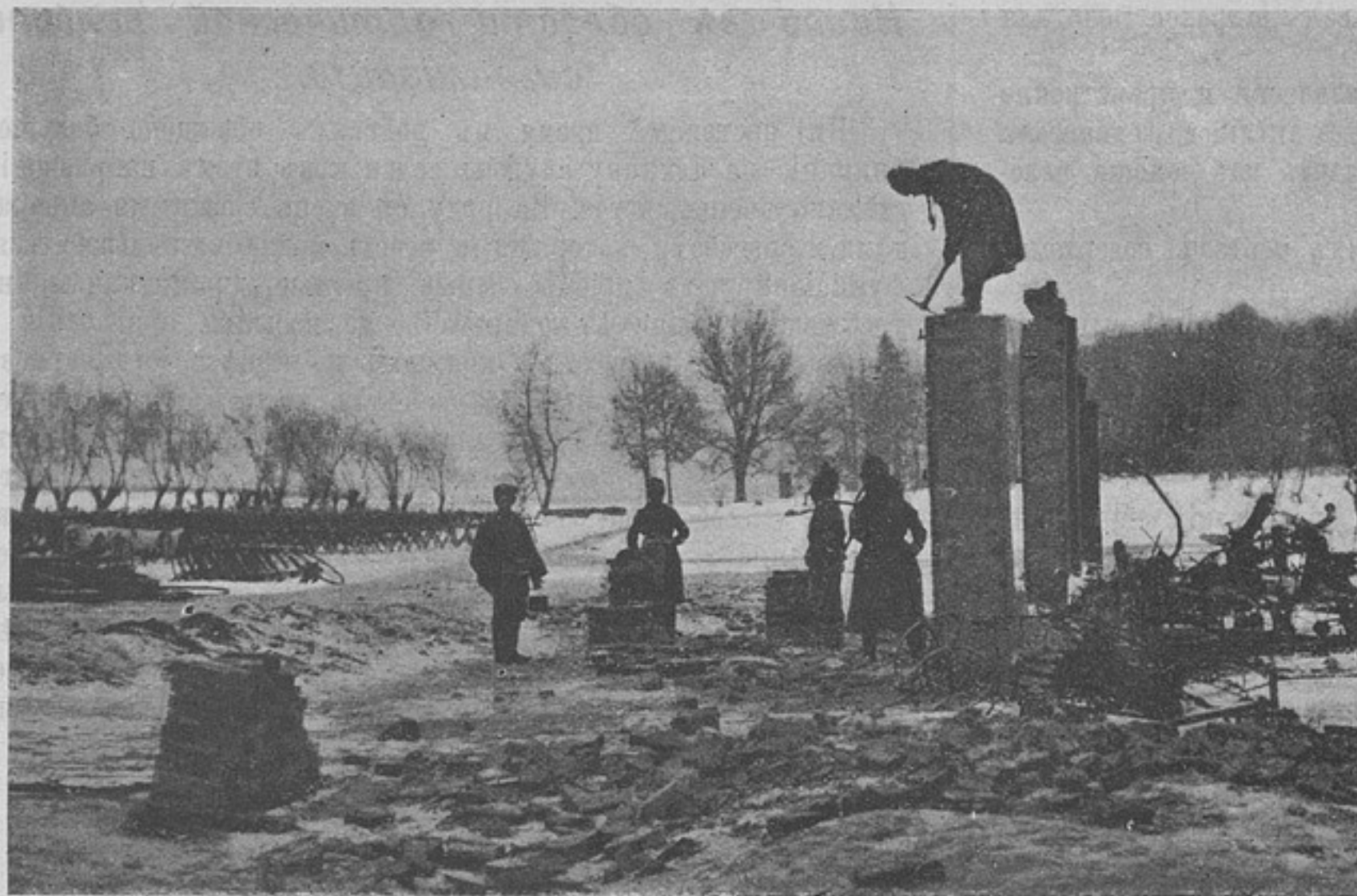
Постройка кашеварами печей на остатках разрушеннаго дома. (Фотогр. шт.-кап. Корсакова.)
