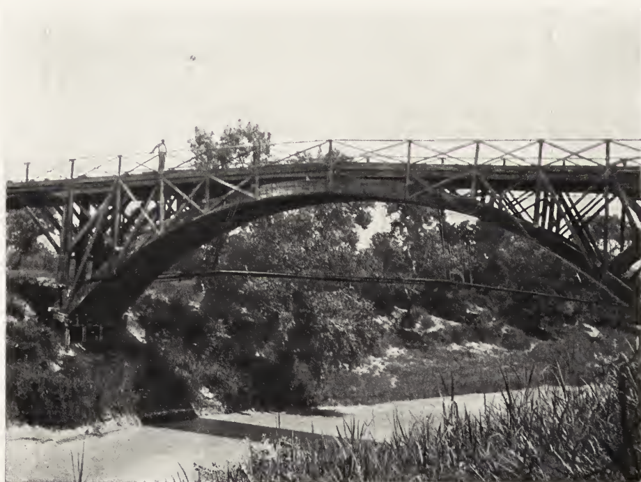
RIPALTA — IL PONTE SUL FORTORE.
