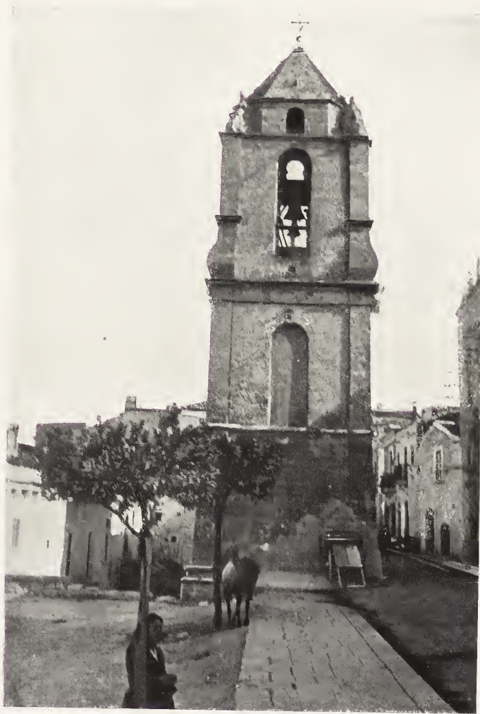
MONTE SANT'ANGELO — UN CAMPANILE.
