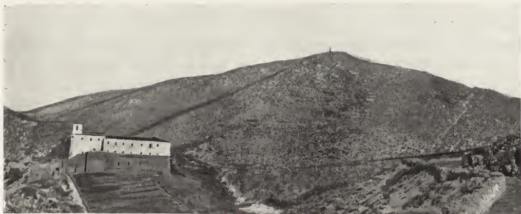
CONVENTO DI S. MATTEO PRESSO SAN MARCO IN LAMIS.
