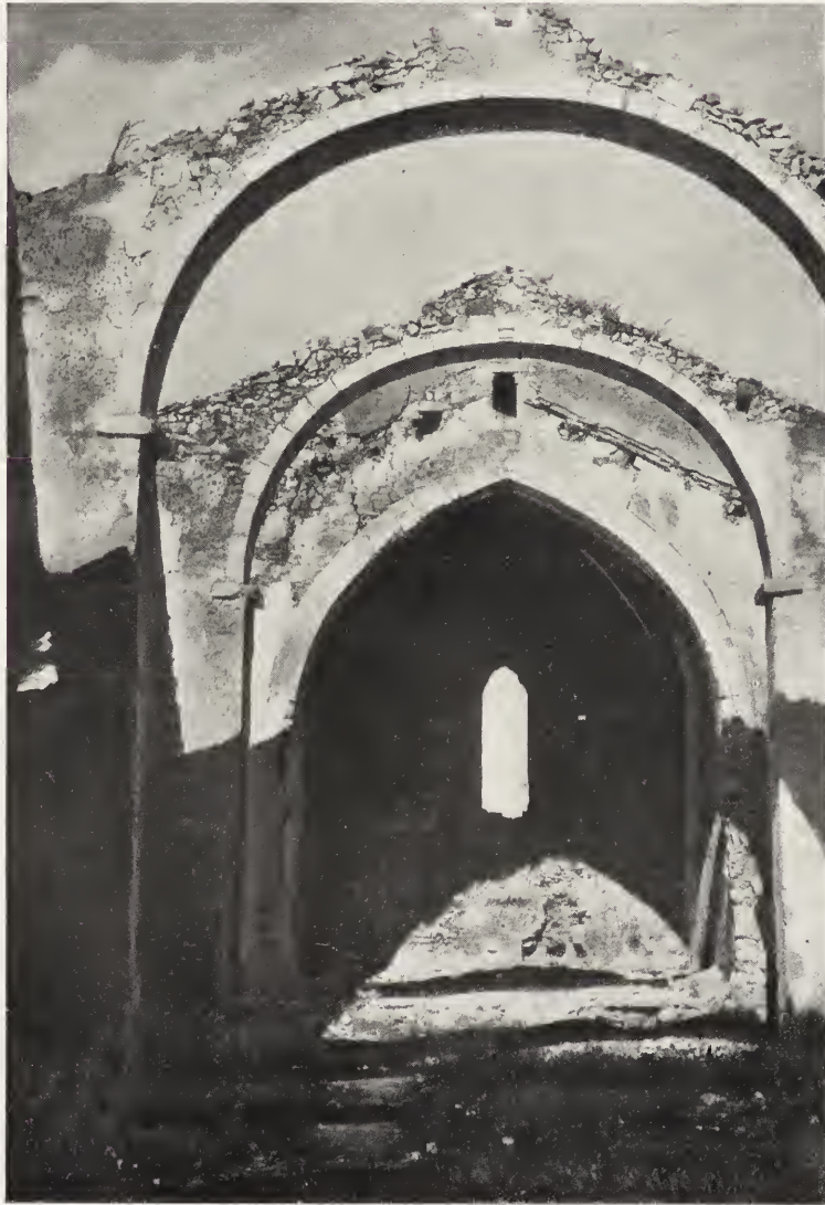
S. GIOVANNI ROTONDO — INTERNO DELLA CHIESA DI S. ONOFRIO. (Fot. Beltramelli).
