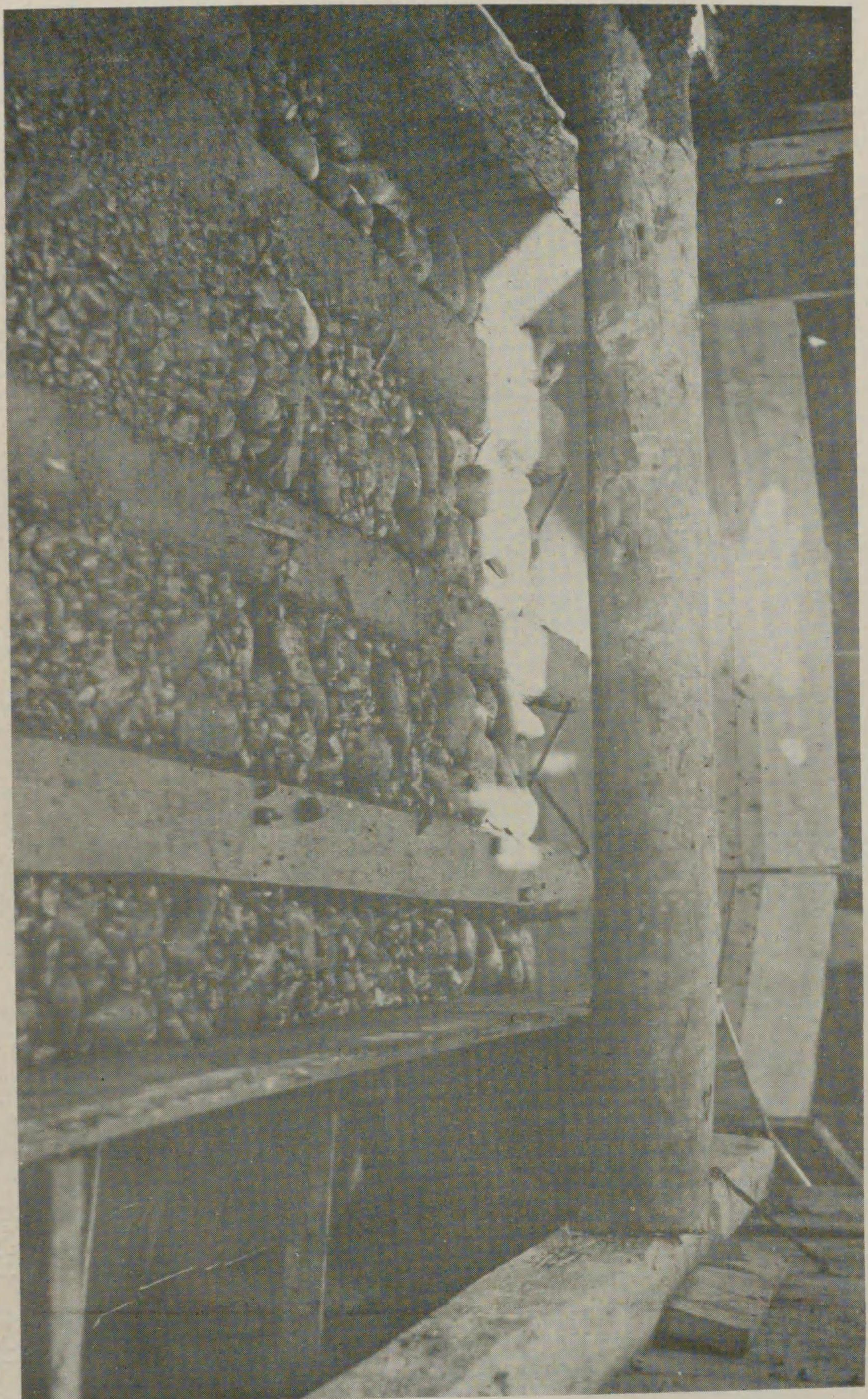
日本紡西角下水埋設基礎工事の状況
