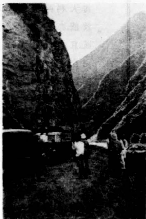
西漢公路大散關開山工程
