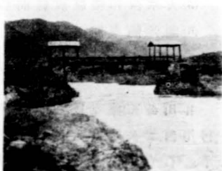
岷縣洮河上游之木橋利用天然岩石以爲橋基
