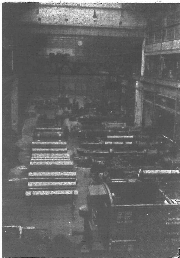
成裝鐵鋼非一無械機與管桶之列排壘壘
