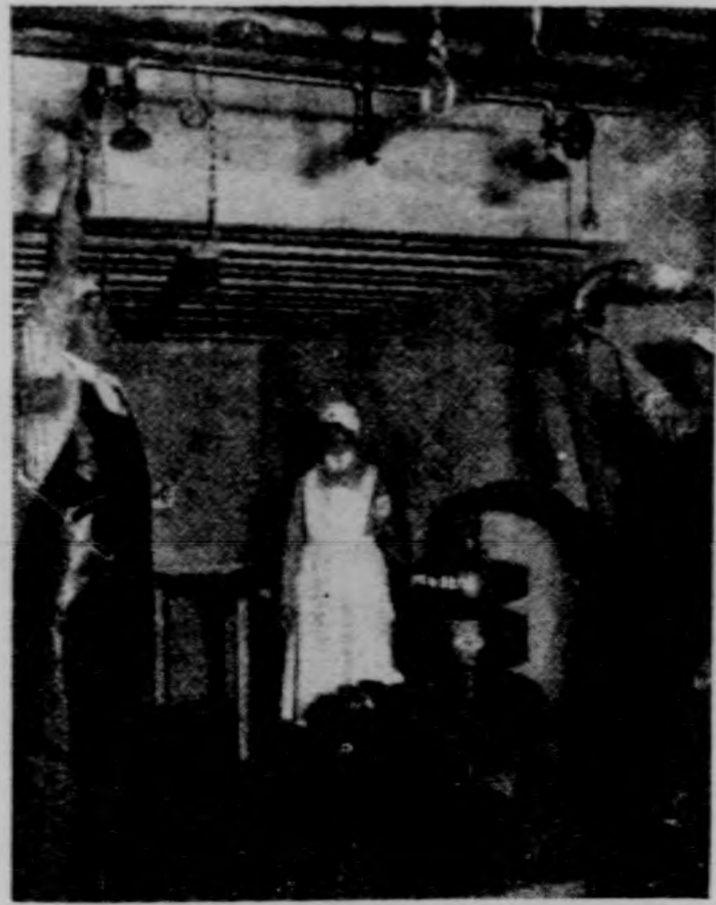
救護所內之灑水浴裝置附通氣裝置
