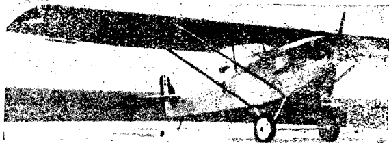
飛厄魯S120戰鬪機——發動機飛厄特500馬力
