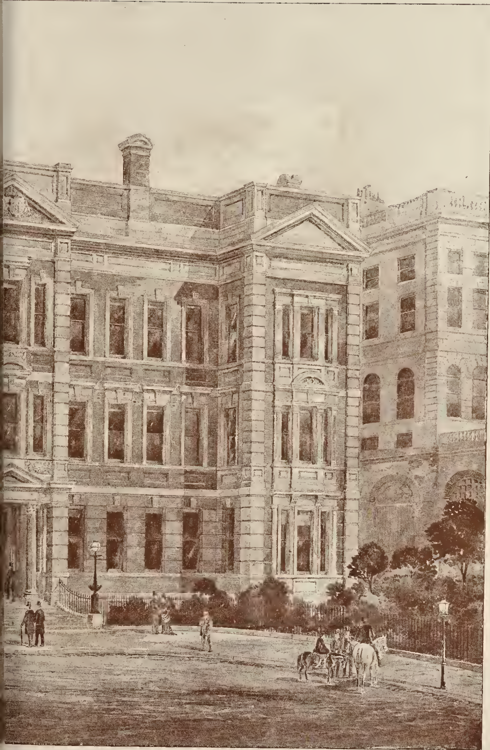
157 PHOTO. SPRUE & CO. LONDON
