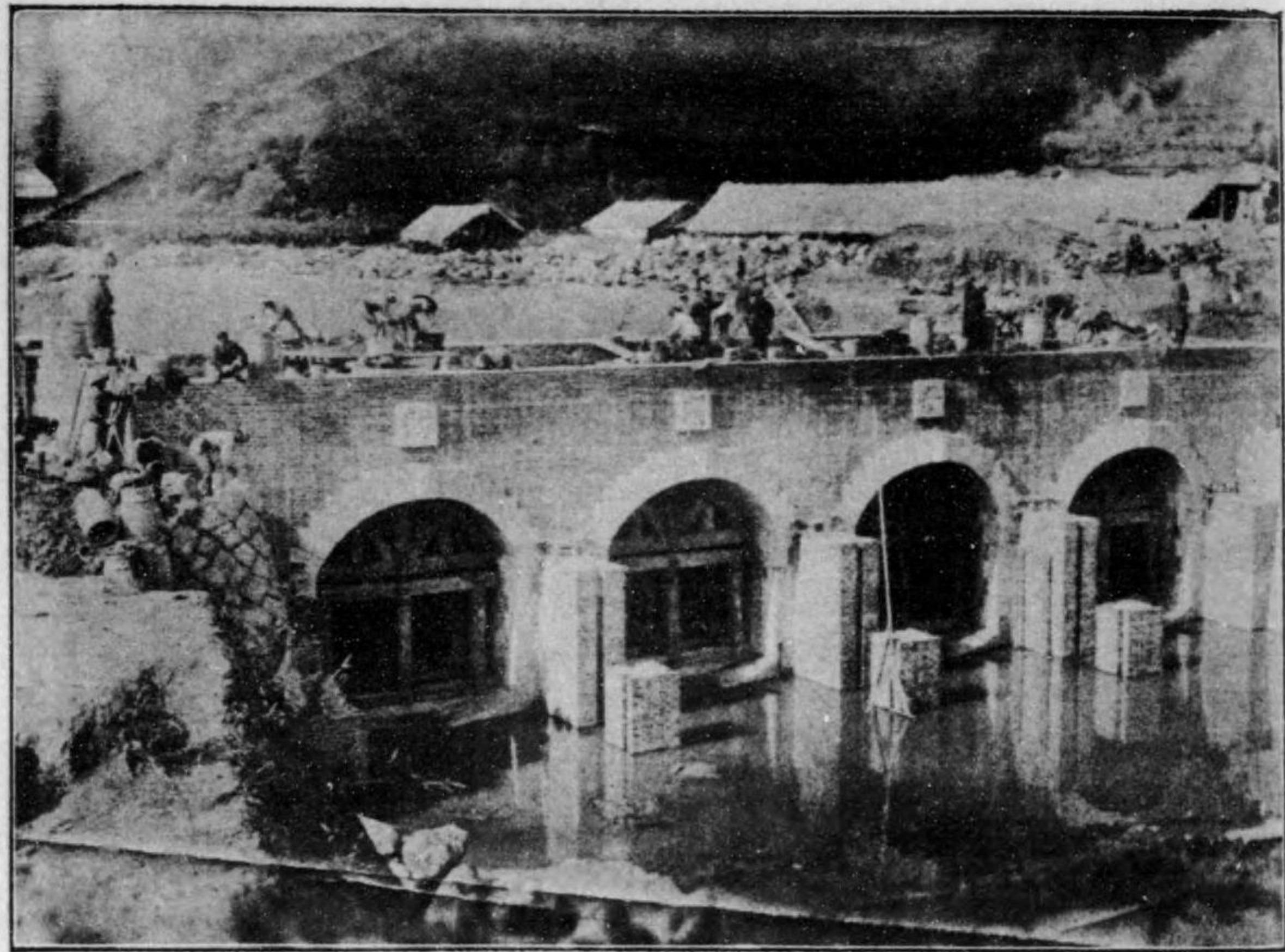
高岡郡下加茂組合神母閘門復混凝土作業中ノ實況
