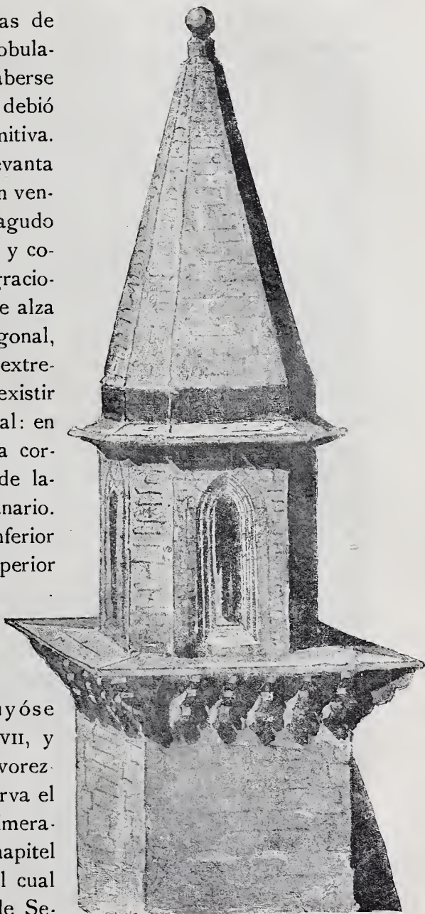
TUDELA.—CATEDRAL.—TORRE DEL EXTREMO S. O. DE LA FACHADA
