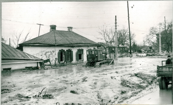
Рис.26 Улица Фрунзе со стороны города, залитая разжиженной массой грунта. Вид направо.
