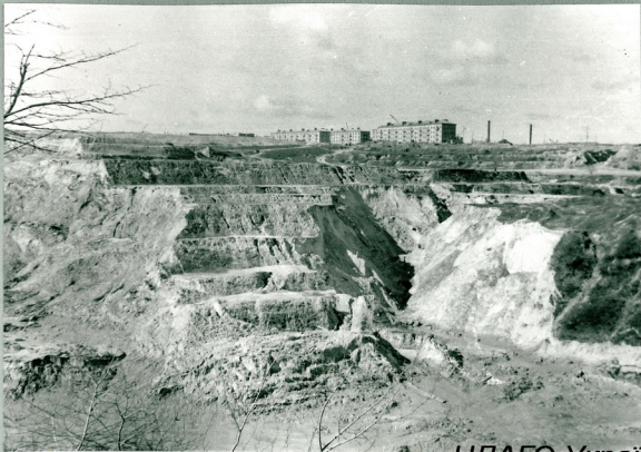
Рис.15 Вид со стороны города на уцелевшую часть дамбы № 1. Слева видна область шлюза, справа размыв и обрушение средней части дамбы.
