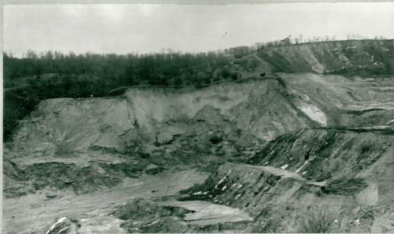
Рис.16 Область выноса на участке № 1. Справа в углу видна уцелевшая часть дамбы № 1, слева - обрушившийся коренной берег.
