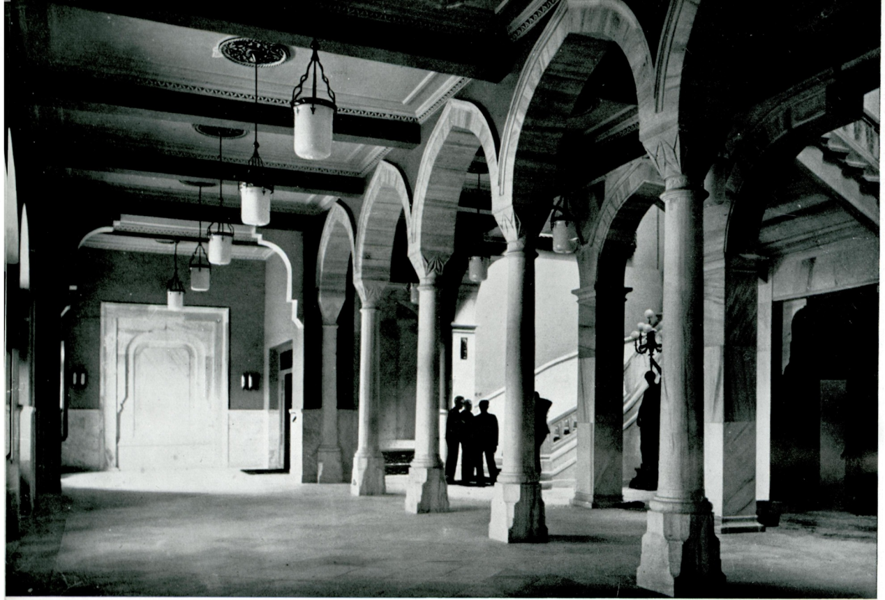
Le hall de marbre et l'escalier
