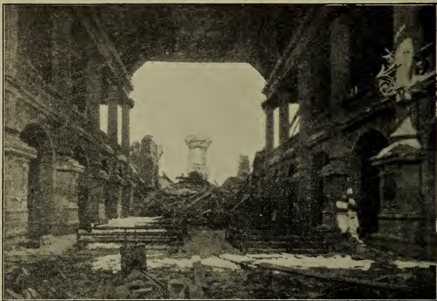
Das Innere des Merced-Tempels in Valparaiso, nach dem Erdbeben am 16. August 1906.
