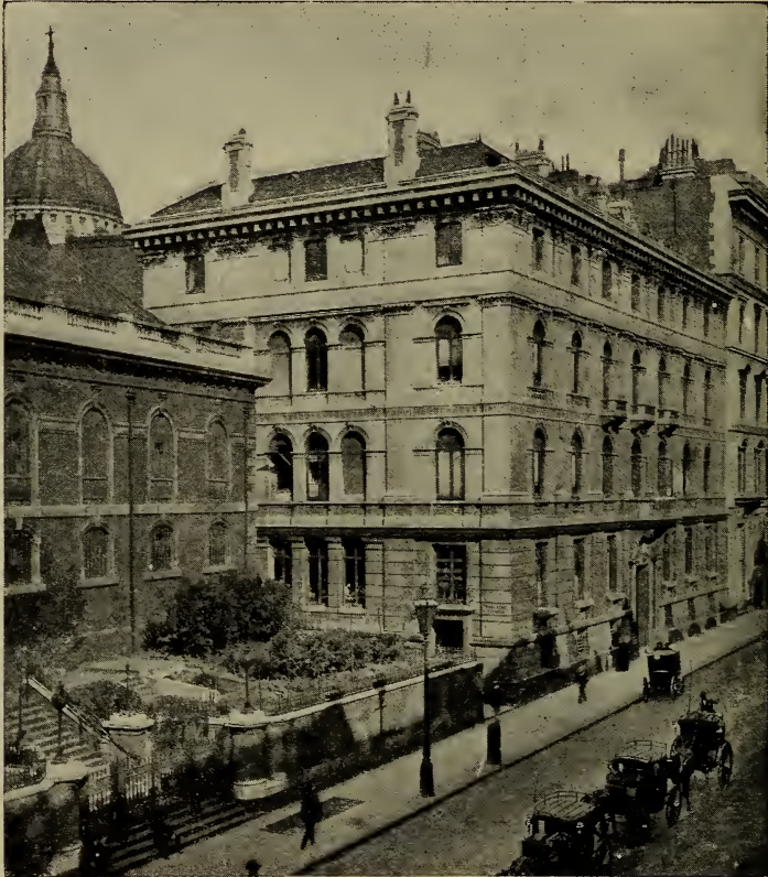
Bibelhaus, Queen Victoriastraße, London, mit dem Dom der St. Pauls-Kathedrale im Hintergrund. Einer der Hauptsätze im Bibelhaus ist eine Sammlung von 10 000 Bibeln in über 500 Sprachen und Dialekten.
