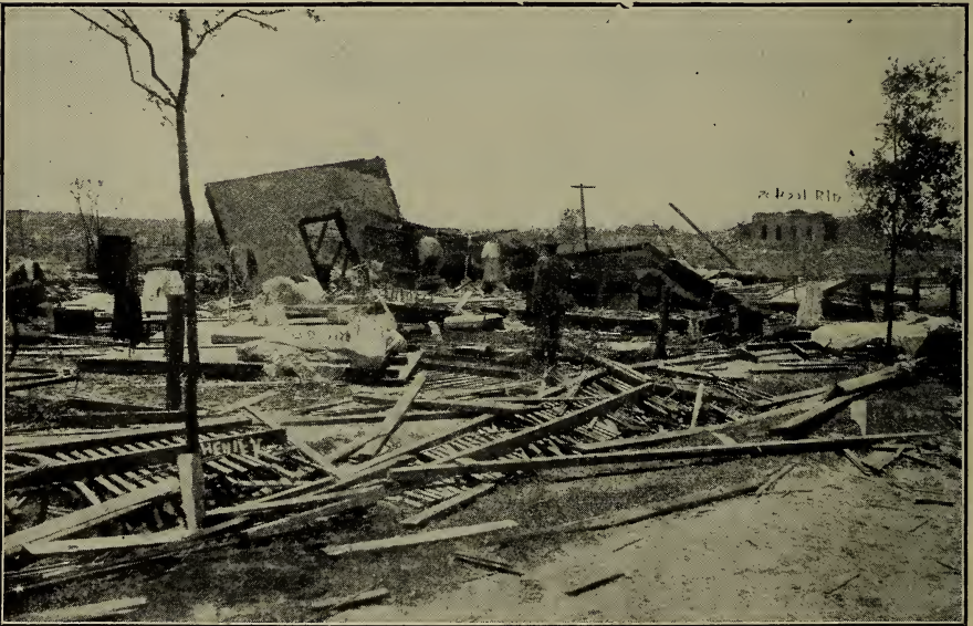
Ruinen auf dem Pfade des Sturmes, welcher Louisiana, Mississippi und Alabama am 24. April 1908 heimguchte. Stürme, welche im Jahre 1908 ähnliche Zerstörungen auf ihrer Ebne hinterließen, suchten Texas, Oklahoma, Minnesota, Nebraska, Kansas, Neu-Mexiko und Iowa sowie Portugal und Ungarn heim.
