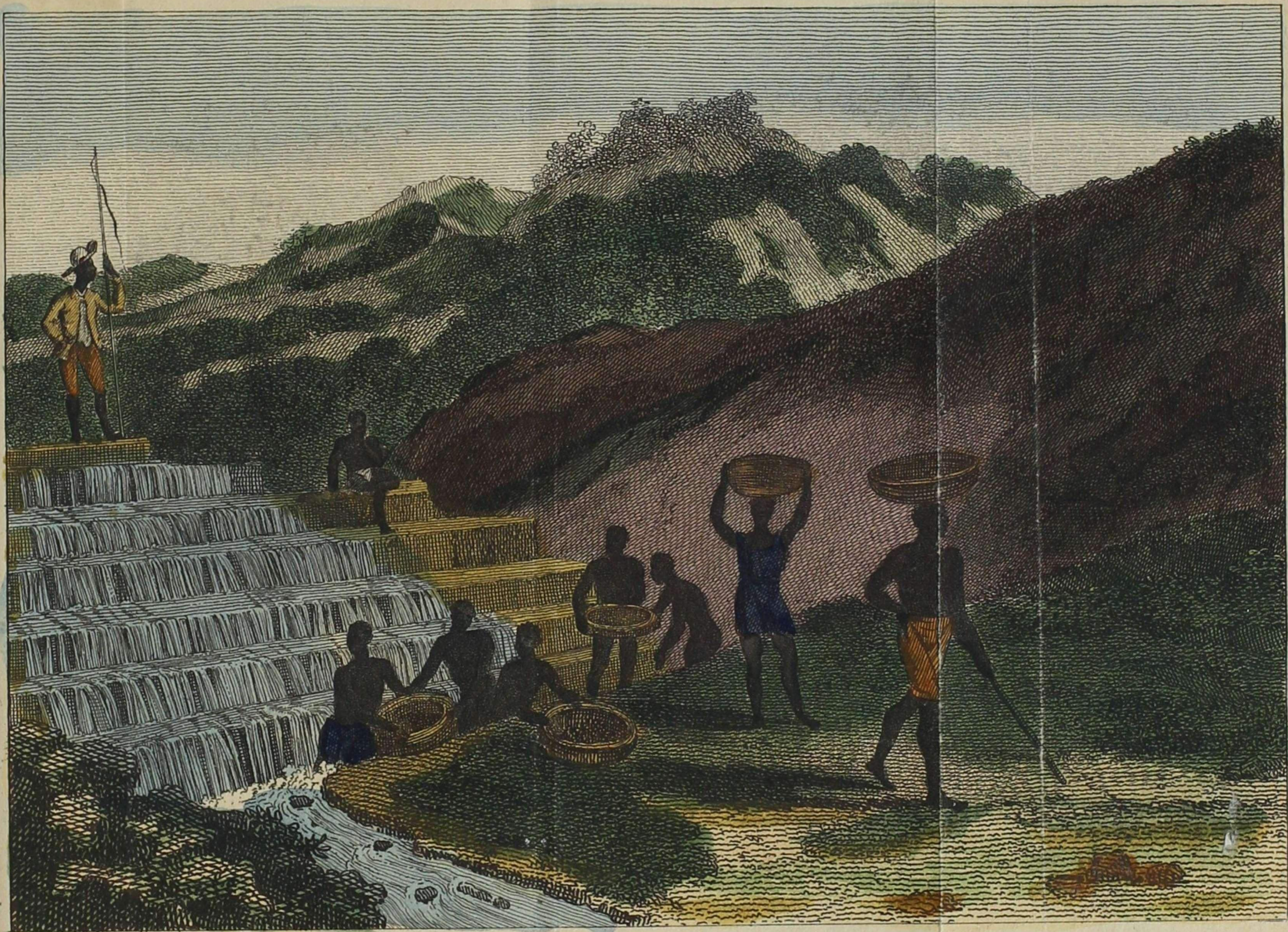
Lavage des Sables aurifères.
