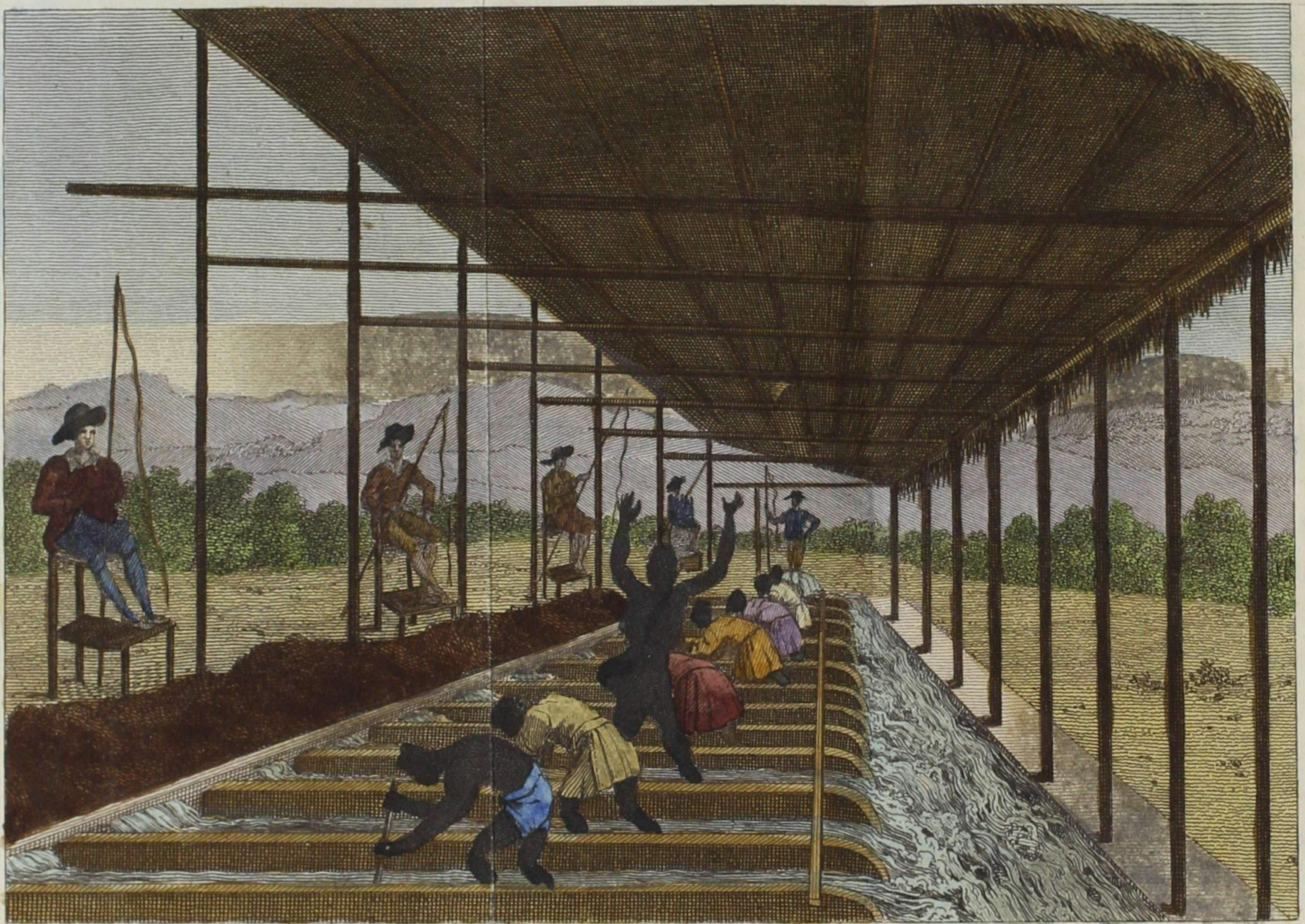
Lavage du Cascalhaon contenant le Diamant.
