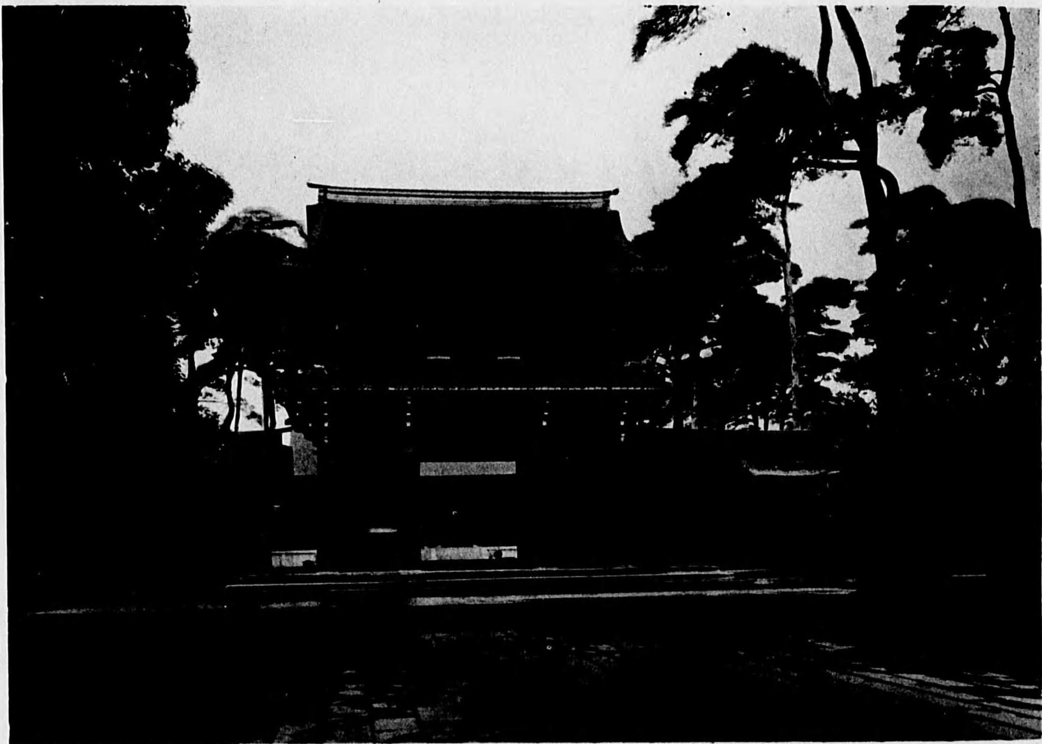
。付み彫柱丸 打具金飾銅金 造木素 尺九三高棟 六六尺五一間梁 尺九二行桁 門 神 南
