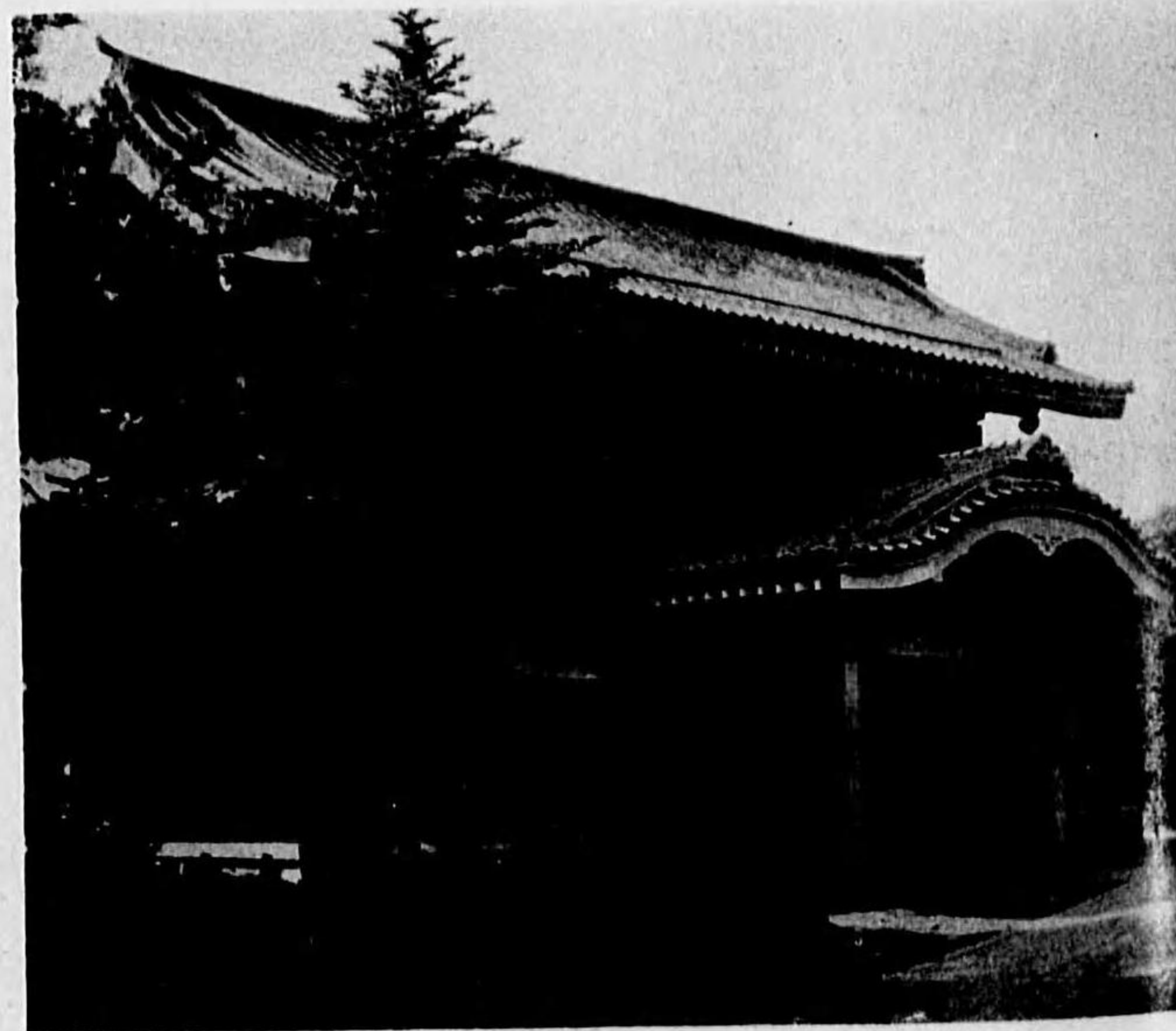
、葺本瓦掛葉根屋 造ト一ツクンコ筋鐵 尺〇三間梁 尺四五行桁 (殿照積) 殿物賣 敷クアルコ 張板拭床 井天格部内
