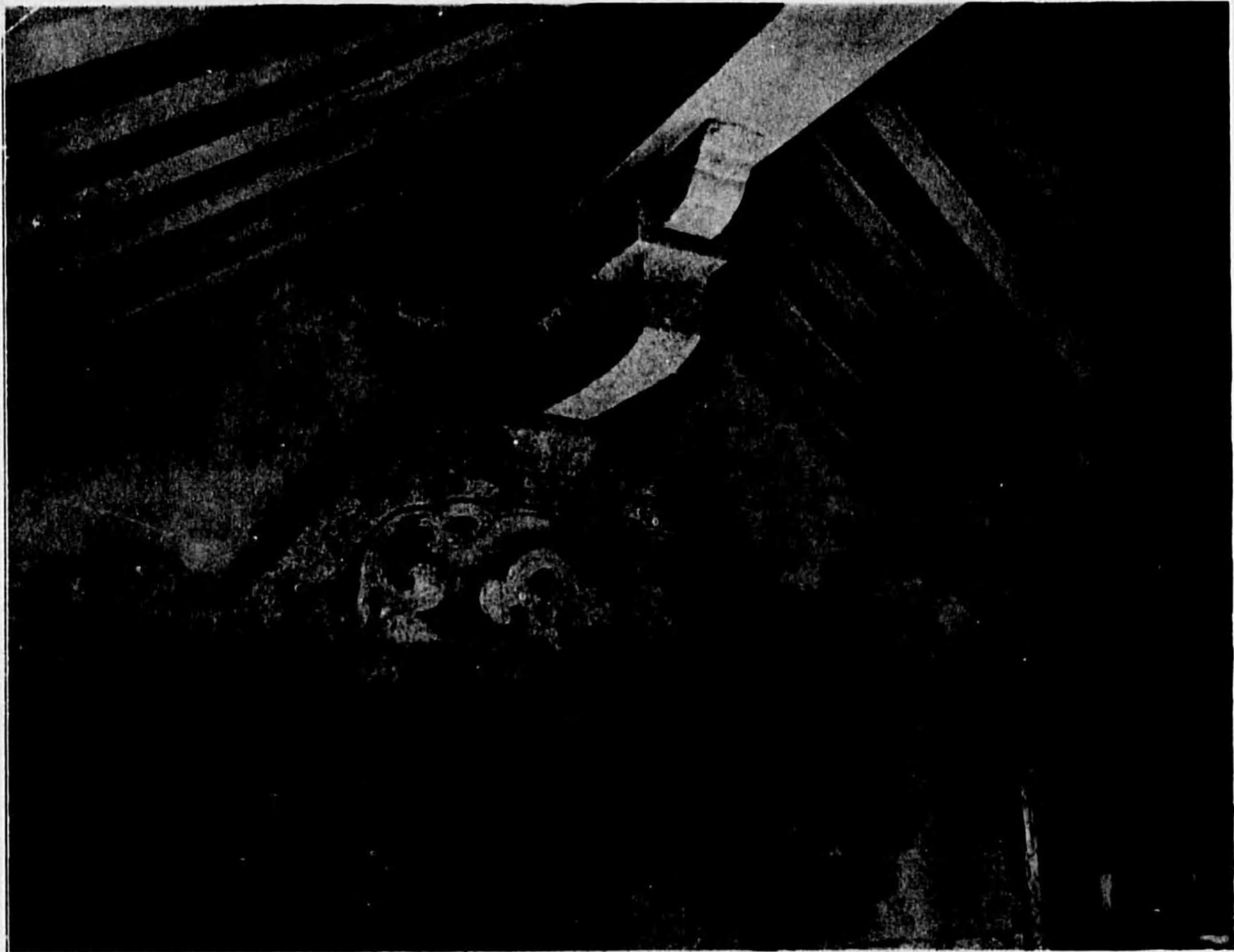
上層妻の一部 斗拱・墓股は紅龍石粗面叩仕上 丸桁・虹梁棟 等は人造紅龍石研出 裏板は人造黃龍石洗出
