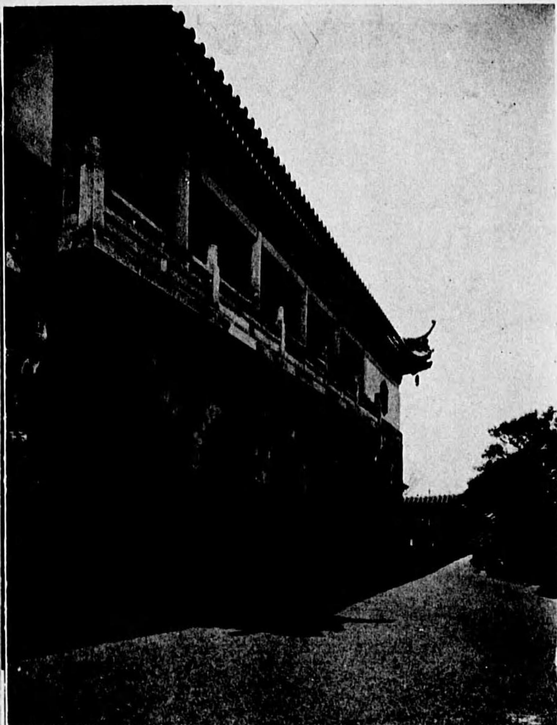
別館車寄上部 天井・樑・柱モルタル塗り ト仕上 懸魚・礎盤ブロンズ製 持懸壁彫 し銅板打出
