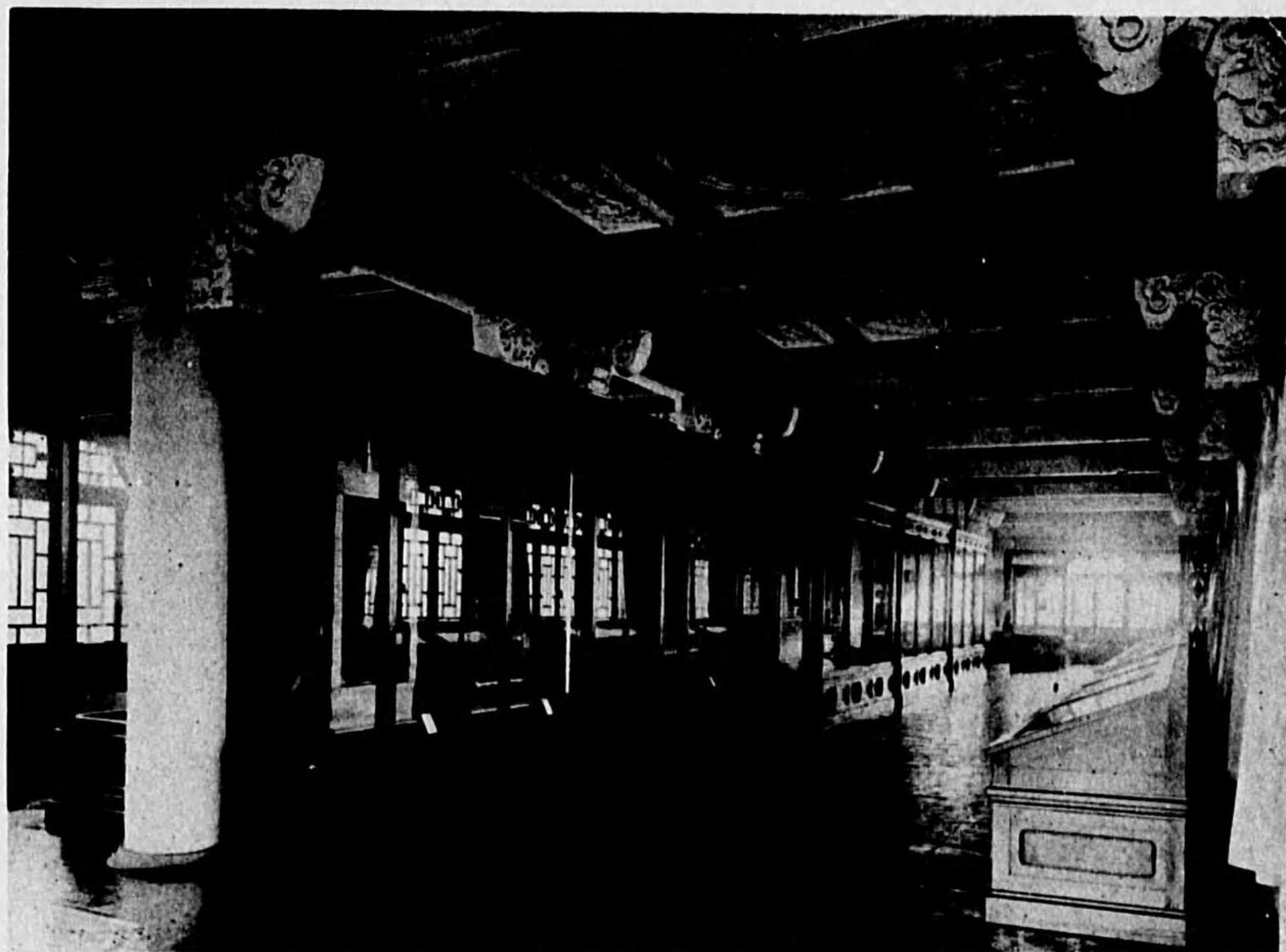
本館二階内部 天井及壁は漆喰塗り、天井持懸等の彫刻は石膏仕上 床はリノリウム敷。
