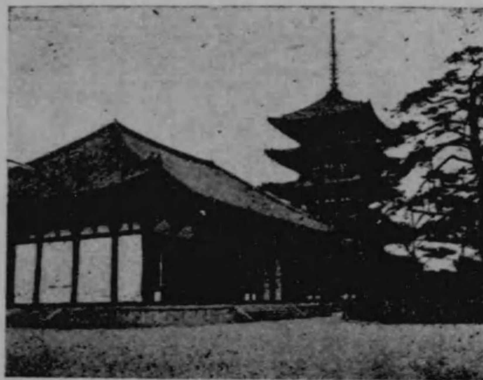
金堂以下の四字は特別保護建造物である。
